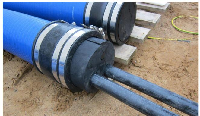
Le manchon KES150 MA WE160 SG SET peut être utilisé à la fois comme bouchon aveugle et pour étanchéifier le tuyau spiralé. La technologie de bagues segmentées permet d'adapter le diamètre individuel du câble sur place.
