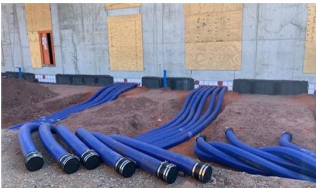
Le tuyau spiralé Hateflex permet de poser des câbles en toute sécurité et en douceur, grâce à ses propriétés de stabilité de forme, de résistance au flambage, de transparence, de résistance aux intempéries et aux U.V.
