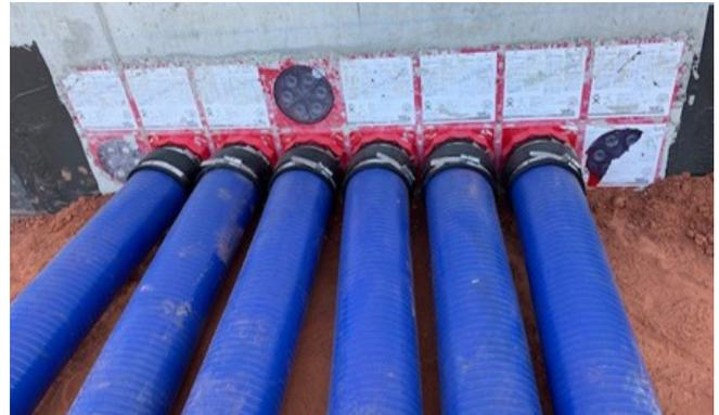
Le raccordement du tuyau Hateflex aux emballages étanches s'effectue via le couvercle du système KES MA150 D.
