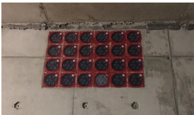
Les passe-câbles non utilisés sont déjà obturés pour une étanchéité permanente de 2 bars à la pression. Grâce au couvercle HSI150 DT transparent, il peut être à tout moment vérifié si de l'eau se trouve dans le passe-câble ou la gaine.
