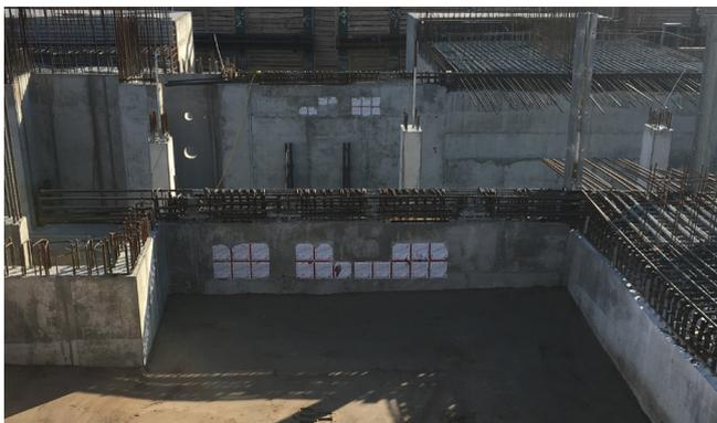
Les passe-câbles HSI150 K2 de Hauff-Technik ont été mis en œuvre pour le raccordement des gaines passe-câbles et pour l'étanchement ultérieur des câbles.
