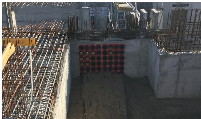
Des gaines passe-câbles lisses d'un diamètre de 160 mm avec couvercles HSI150 M168 ont été raccordés par couche aux passe-câbles. L'instantané indique ici la première couche de gaines passe câble.
