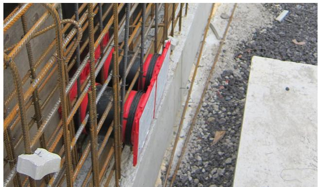
Kabelski uvodi ugrađeni su u pojačanja te se na predviđenim rupama za spajanje čavlima pričvršćuju na oplate.
