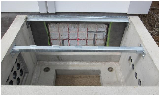
Ispred zgrade se u području kabelskih uvoda na određenim dijelovima postavljaju kanali za kabelske vodove odnosno kontrolna okna. Na taj se način olakšava naknadno postavljanje kabela u kabelske uvode.
