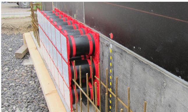
Na različitim stranama pogonske zgrade ugrađeni su kabelski uvodi u različitim paketima. Pomoću rasporeda paketa omoguće se visoka gustoća postavljanja za priključak elemenata, kao što su primjerice kabelske zaštitne cijevi.
