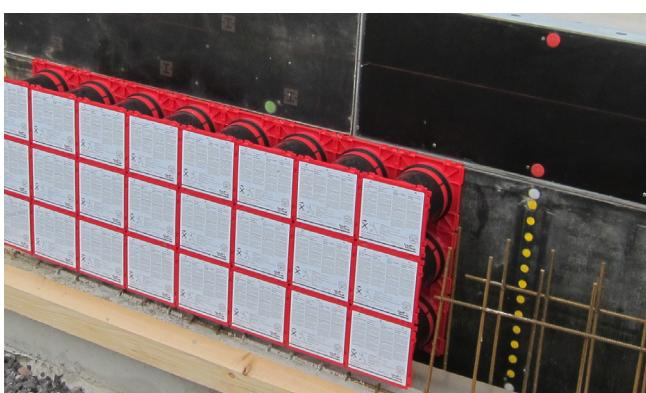
Svi su uvodi standardno zatvoreni pomoću nepropusnog slijepog brtvenog poklopca HSI150 DT koji sprečava moguće prodiranje vode. Brtveni poklopac nalazi se ispod zaštitne folije.
