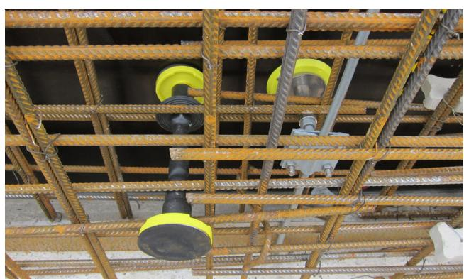
Za uzemljenje odnosno izjednačavanje potencijala koriste se različiti uvodi uzemljenja i priključni svornjaci. Ugrađuju se u pojačanja te se zatim pričvršćuju. Priključni svornjaci se prije betoniranja spajaju na vodove za izjednačavanje potencijala.
