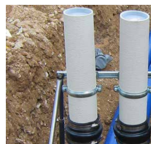
Disposición en línea 2x KES90 MA ZVR100/500 en el dispositivo de ajuste KES FUBO-FIX AV
