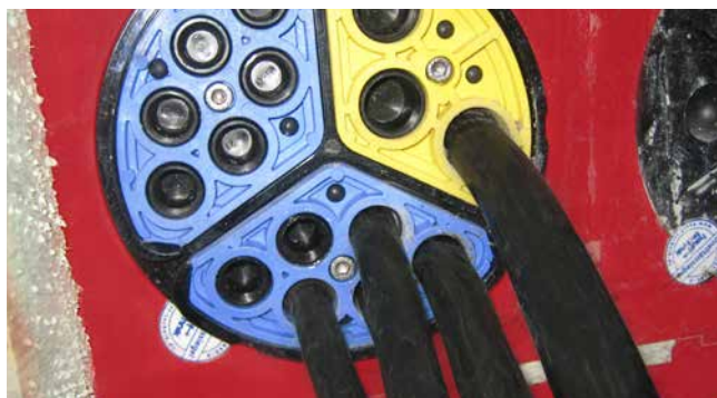
HSI150 – SEGMENTO – con control de par integrado y tapones ciegos
