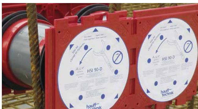
Inserto de pared doble HSI90 como paquete empleado en encofrado
