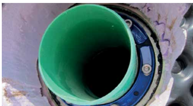
HSD150 C 1x110 b40 A2/EPDM55 con brida fija y suelta galvanizada
