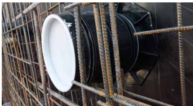
UFR en encofrado
