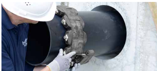
GKD400 – colocación de los segmentos
