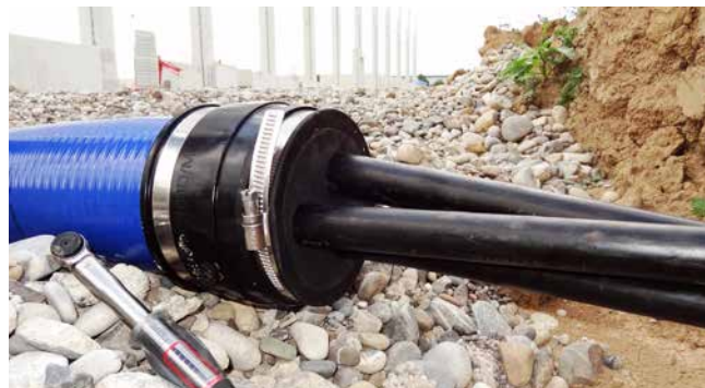
Sellado en el suelo del extremo de la manguera espiral Hateflex14150 con el kit de sellado KES150 MA WE 160 SG 3x22-58 SET
