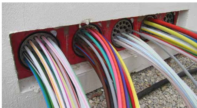
Inserto de pared HSI150 equipado con HRD 150 21x14 b60 A2/EPDM55 para el sellado de micro tuberías.
