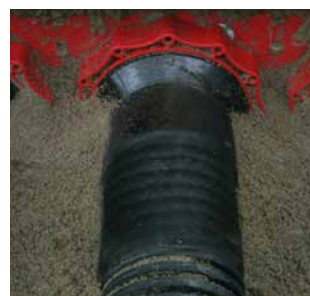
Conexión de tuberías corrugadas con tecnología de retracción en frío HSI150 D1x110 KS WR
