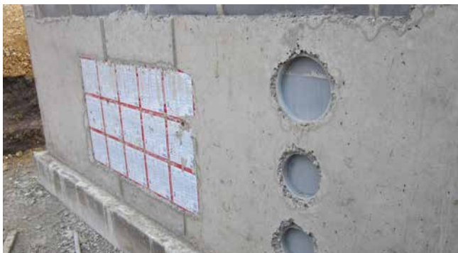
ZVR150 y ZVR200 hormigonado junto a HSI150
