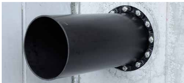
GKD400 – finalización del montaje
