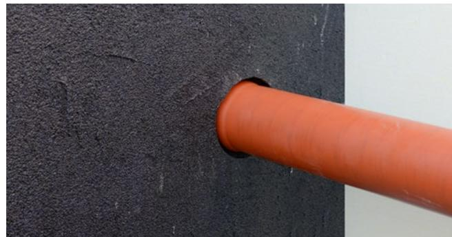
Praxisbild UDM/UDME eingebaut mit angearbeiteter PMBC-Beschichtung und angeschloss-nem KG-Rohr
