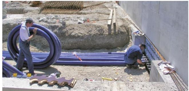
Verlegung Kabeleinführungs-System KES150 MA mit Manschetten-technik
