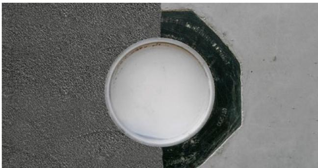
Betoniertes UFR mit PMBC
