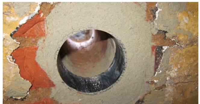
SFR - für Hohlkehlenanschluss mit PMBC Dickbeschichtung - Einbau nach DIN 18533
