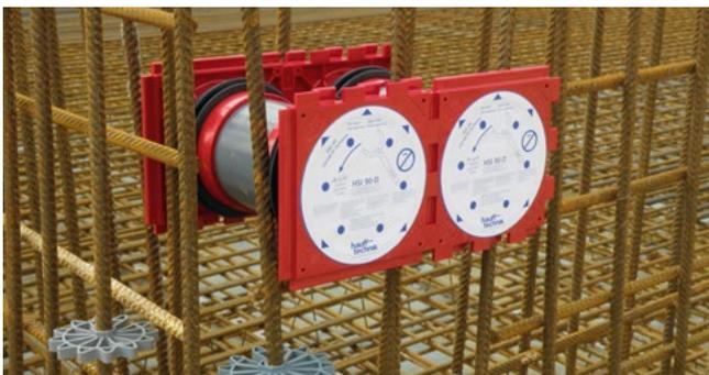
Doppeldichtpackung HSI90 als Paket in Schalung eingesetzt
