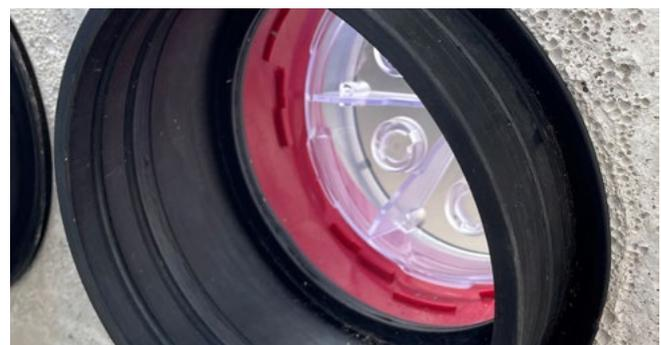
HSI150 KMA, Einfach-Dichtpackung mit klappbarer Gummimanschette
