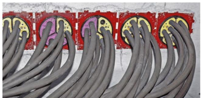
Kabelzug durch HSI-Dichtpackungen mit SEGMENTO-Systemeinsätzen
