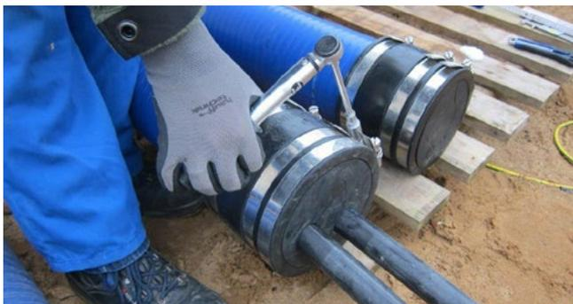
Druckdichter Anschluss des Hateflex14090 an die Dichtpackung HSI90 sowie Endabschluss für das Kabelschutzrohr
