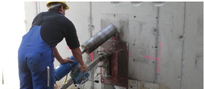
Herstellen von vertikal und horizontal verlaufenden Diamantschrägboreungen für die Aufnahme von HRD-Dichteinsätzen
