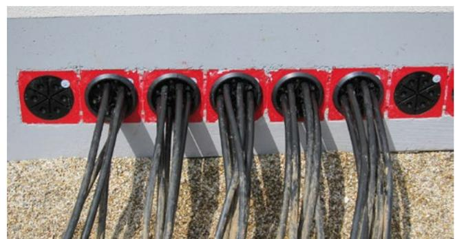
Abdichtung von Niederspannungskabeln mit HSI150 DG 6x10-36
