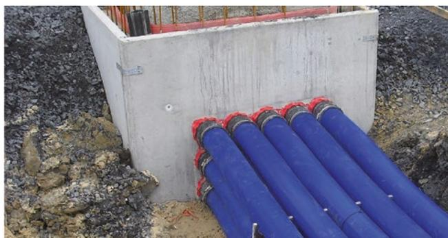
KES MA90 D - Anschluss an Dichtpackung HSI90
