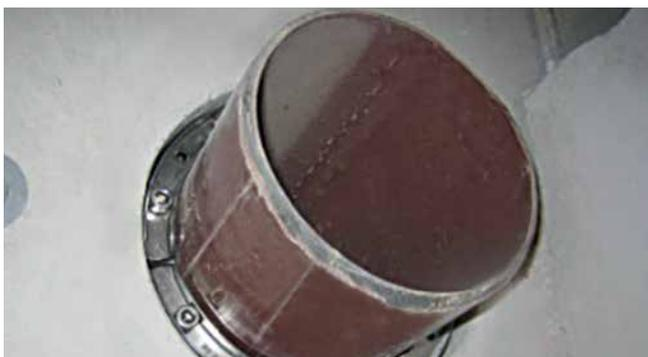
HSD200 1x160 b40 A2/EPDM55 Entwässerung SML Rohr
