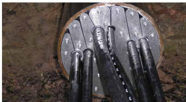
HRD200 G b30 in einem Stahlrohr
