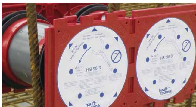
Doppeldichtpackung HSI90 als Paket in Schalung eingesetzt
