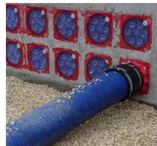
Druckdichter Anschluss an die HSI150-Dichtpackungen
