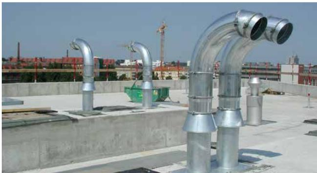
Montierte SHD200 vor Verlegung der Dachabdichtung
