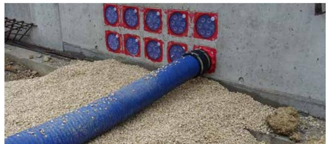
Anschluss des Kabeleinführungssystems KES MA150 D
