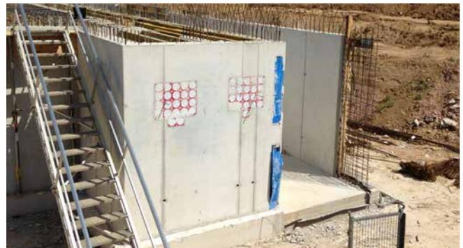
Paket HSI90 Doppel-Dichtpackungen nach dem Betonieren:
