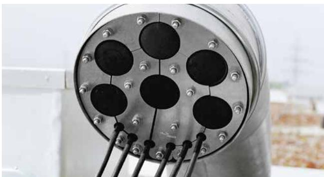
Montierter Dichteinsatz SKD in Schwanenhals SHD200
