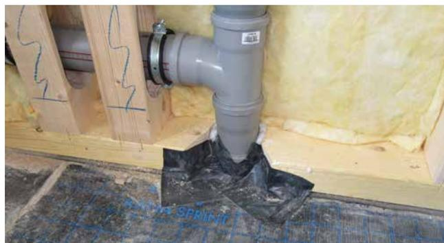
Schwierigkeit: Einbindung der Dampfsperre
