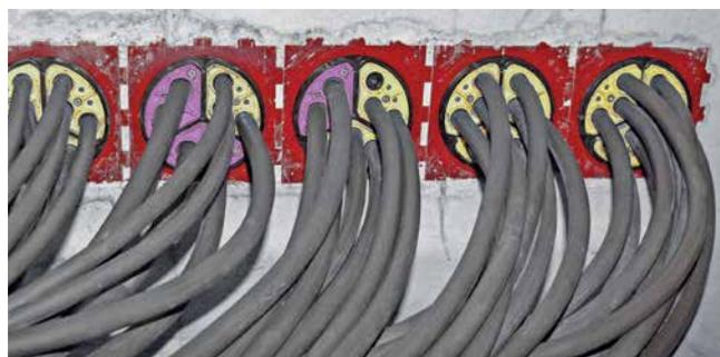
Kabelzug durch HSI-Dichtpackungen mit SEGMENTO-Systemeinsätzen
