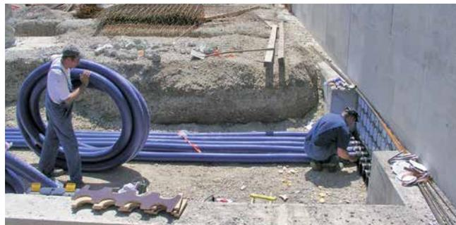
Verlegung Kabeleinführungssystem KES-M 150 mit Manschettentechnik
