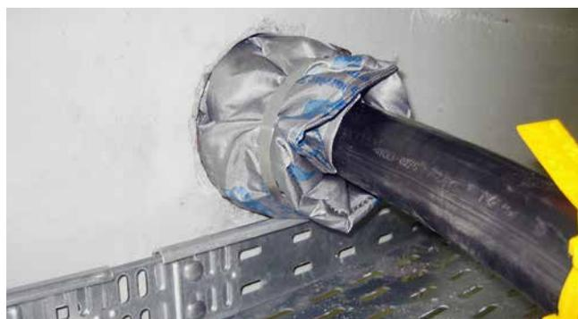
HSS – Einbau in Kernbohrung mit HRD Ringraumdichtungen
