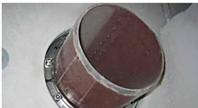
HSD200 1x160 b40 A2/EPDM55 Entwässerung SML Rohr
