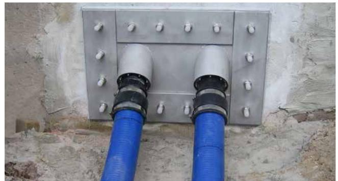
Fest-/Losflansch mit schräger Leerrohranbindung vor Flächenabdichtung
