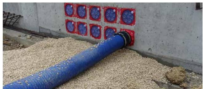
Anschluss des Kabeleinführungssystems KES MA150 D
