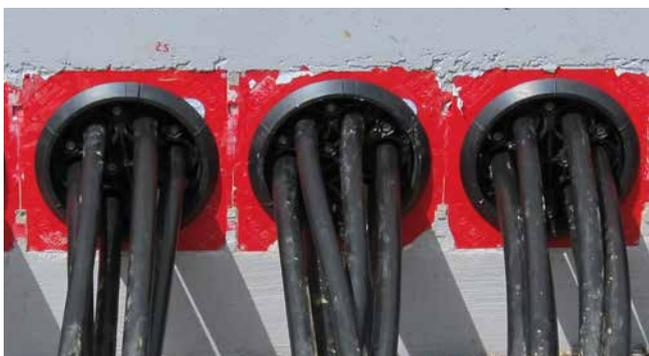
Abdichtung von Niederspannungskabeln mit HSI150 DG 6x10-36
