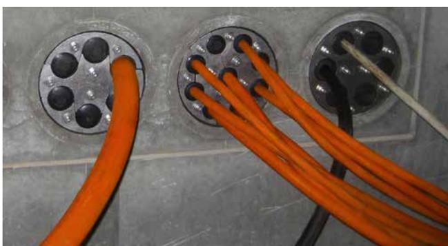
HRD150 SG eingebaut in Faserzementfutterrohre
