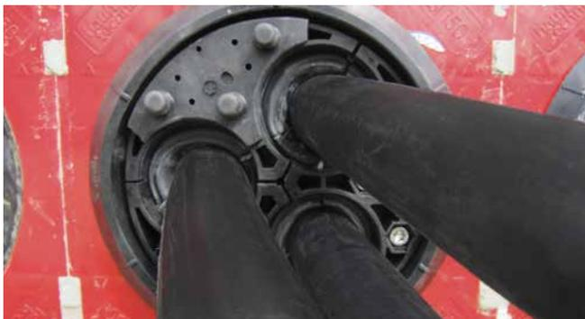
Pressplattenabdeckung HSI150 DG PA 3x24-54
