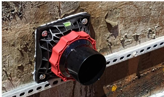
La copertura del sistema HSI è stata quindi semplicemente fissata alla flangia DFK tramite il sistema a baionetta ed è stata serrata mediante la ghiera di serraggio rossa.
