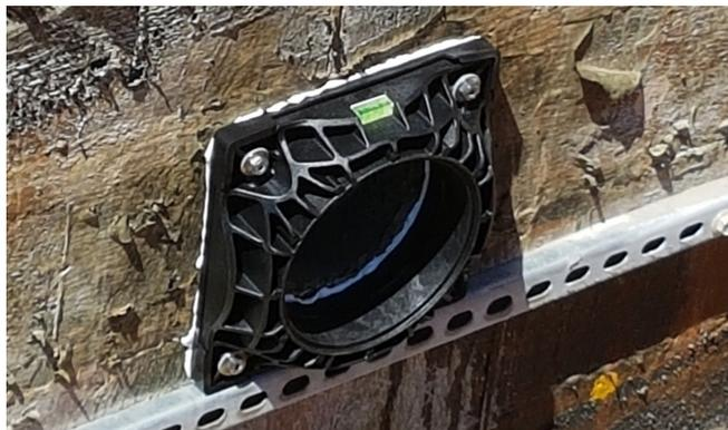
La flangia da parete HSI 150-DFK e il sigillante sono stati posizionati sul foro centrale e sono stati fissati tramite viti e tasselli a tenuta stagna.
