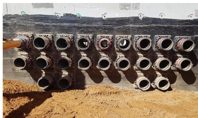
KME ne ha provati tre per iniziare. Il costruttore ha quindi approvato il sistema e ha completato un altro strato della membrana. Sono stati praticati nuovi fori centrali e, dopo un successo iniziale e una facilità d'installazione, sono state installate altre ventidue flange HSI 150-DFK e altre coperture del sistema.
