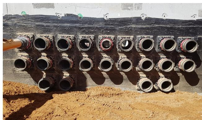
KME hizo pruebas iniciales en tres unidades. Después, el constructor aprobó el sistema y completó otra capa de la membrana. Se perforaron nuevos orificios de núcleo y, de acuerdo con el éxito inicial y la facilidad de instalación, se instalaron otros veintidós HSI 150-DFK y cubiertas del sistema.
