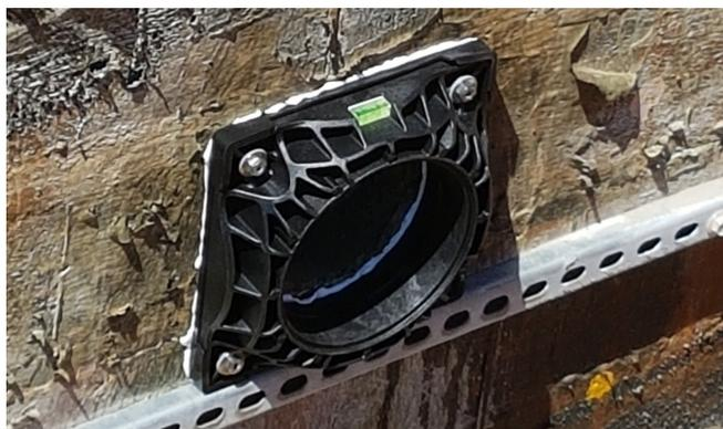
La brida de pared HSI 150-DFK y el sellador se colocaron sobre el orificio de núcleo y se fijaron con clavijas y tornillos estancos al agua.
