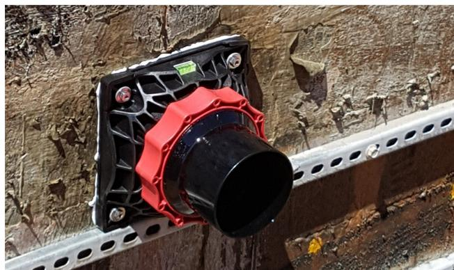
A continuación, la cubierta del sistema HSI se unió al DFK mediante el sistema de bayonetas y se apretó con la tuerca de retención roja.
