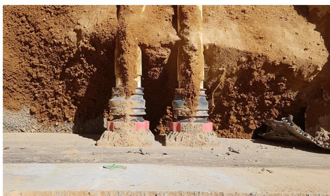
Luego, el conducto se conectó con el casquillo conector de goma incluido con la cubierta del sistema.
