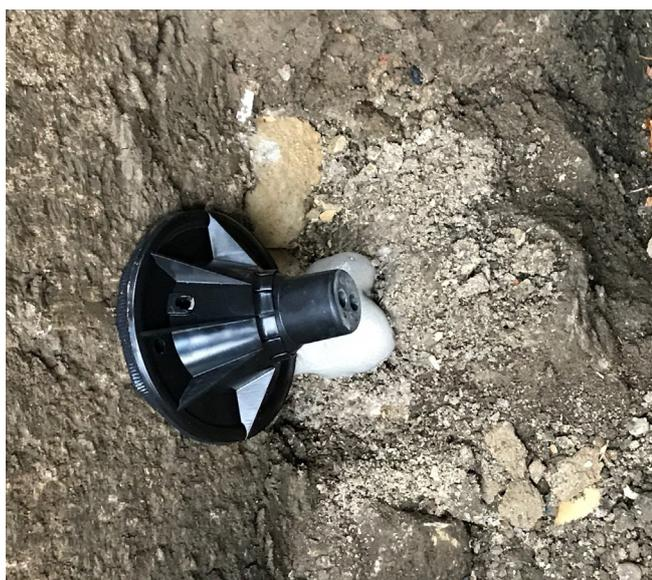
Las irregularidades de la pared se compensan con la resina de expansión de 2 componentes expulsada, consiguiéndose la estanqueidad al gas y al agua.
