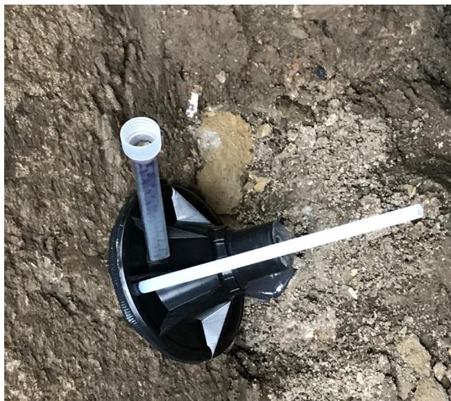
El aire puede escapar a través de la manguera blanca de llenado introducida. La cinta de butilo garantiza una unión estanca entre la superficie de la pared/el aislamiento del edificio y la brida.
