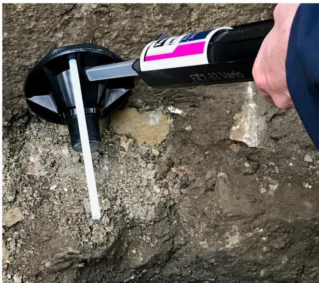
El sellado de la entrada se realiza profesionalmente con la ayuda de resina de expansión de 2 componentes a través de una apertura de 30 mm creada por el constructor hacia la pared exterior.
