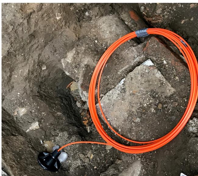
La entrada GFH 30 permite introducir una tubería Speedpipe de 7-10 mm de forma profesional.
