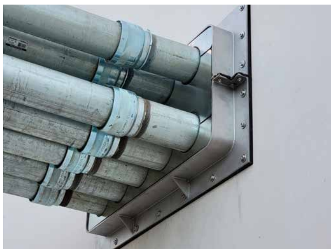
Roestvrijstalen flens gespleten om achteraf in te pluggen
