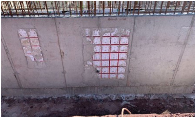
Um ein druckdichtes Leerrohrsystem zur Kabelverlegung zu gewährleisten, wurden mit einem HSI150 K2 System die Durchführungen durch die Schächte realisiert.
