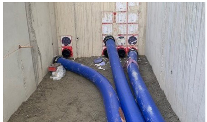
Zum Anschluss des Spiralschlauches an die HSI150 K2 Doppeldichtpackungen wurden die passenden Systemdeckel KES MA150 verwendet.
