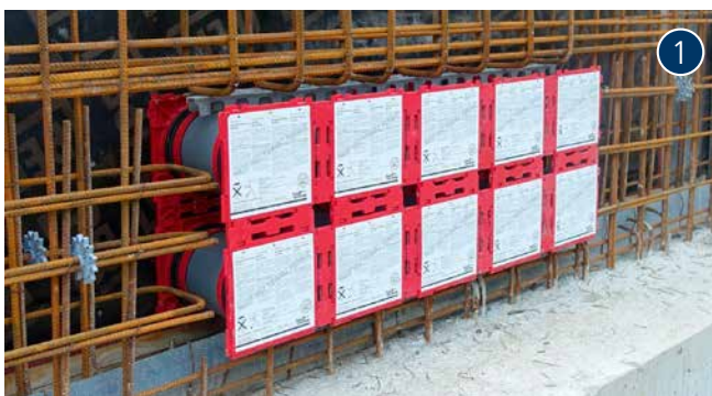
1 Installazione di un passaggio impermeabile doppio HSI150 K2 prima della gettata di calcestruzzo
