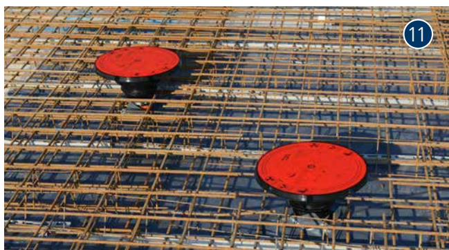
AT110 prima della gettata di calcestruzzo
