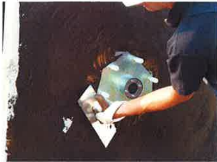
Abbildung 2.1: Auftrag der 1. Schicht PCI Pecimor® 2K
