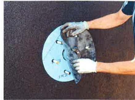
Abbildung 2.2: Anbringen der Gummizulage Z-100 FUF(A)
