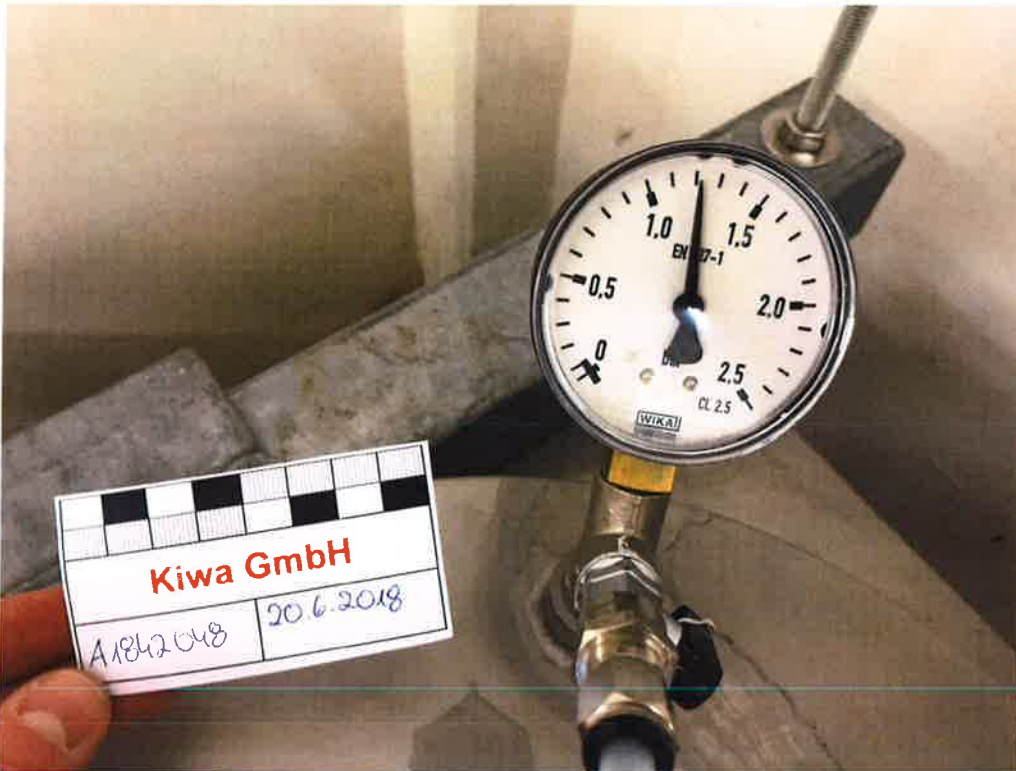
Abbildung A1. Druckdichtigkeitsprüfung der mit wassergefüllten Druckglocke bei einem Nenndruck von \geq 1 bar (Manometerstand bei Versuchsbeginn am 20.06.2018).
