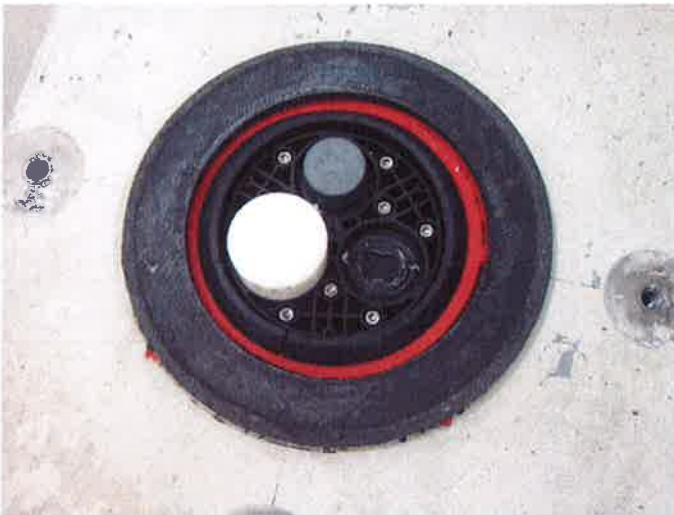
Abbildung 3: Eingebauter Systemdeckel HSI 150-DG-3/24-54 in der Kabeldurchführung HSI 150-K
