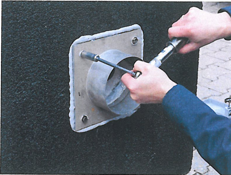
Abbildung 3: Montage Flanschplatte (Bild Hauff-Technik GmbH & Co. KG)
