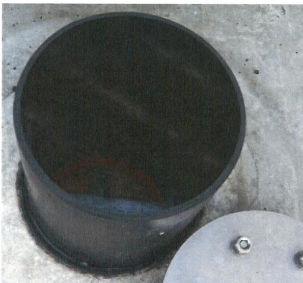
Abbildung 6: Ansicht - Einfach-Dichtpackung mit Gummi-Steckmuffe nach Abnahme des Blindeinsatzes
