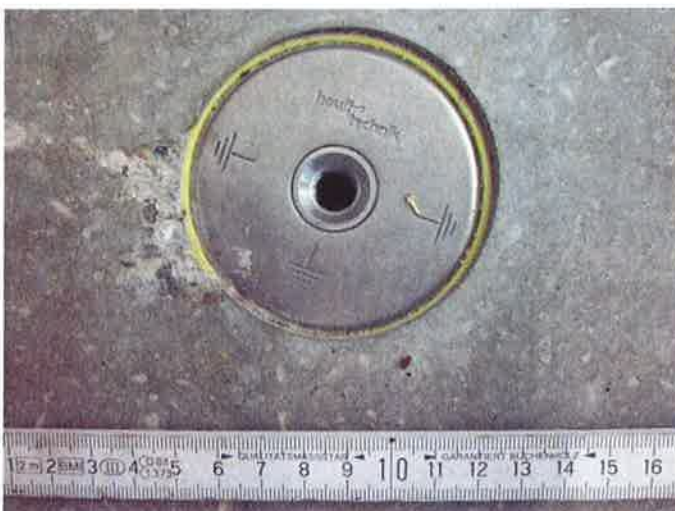
Abbildung 2: Erdungsdurchführung HEA-IS-M12/100, Betonwanneninnenseite
