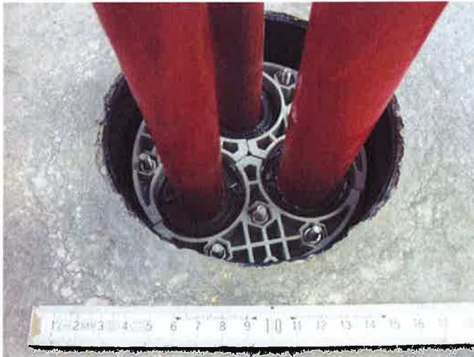
Abbildung 3: HSI 150-DG, Betonwanneninnenseite
