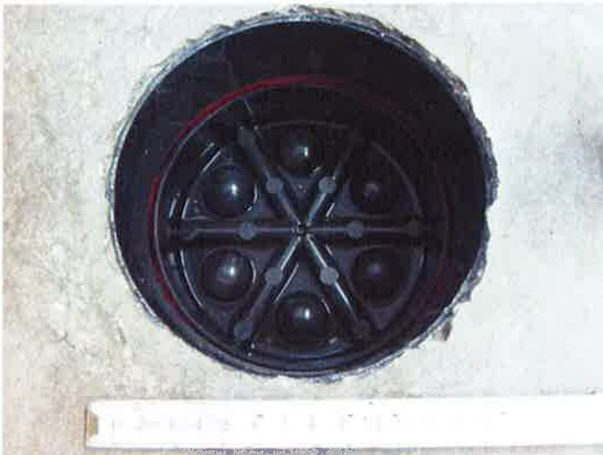
Abbildung 4: HSI 150K/100 mit HSI 150-D, Betonwanneninnenseite
