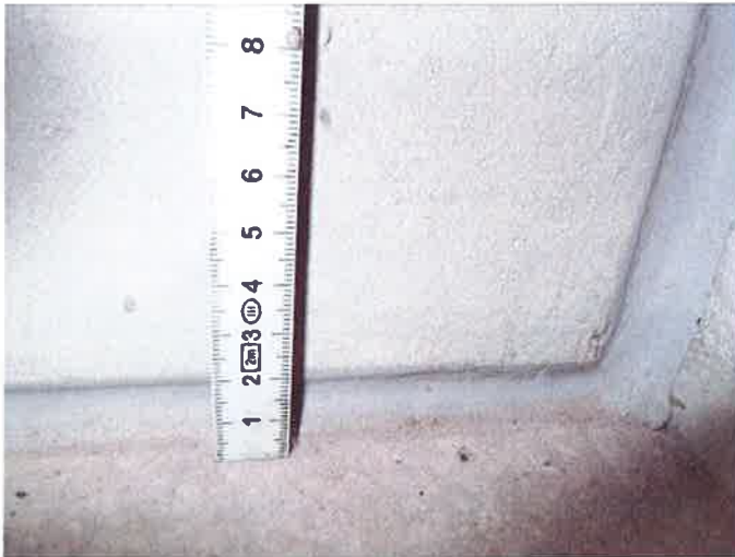
Abbildung 26: Abdichtungsfuge Sikaflex-Tank N auf der ölabgewandten Seite nach 92 Tagen
