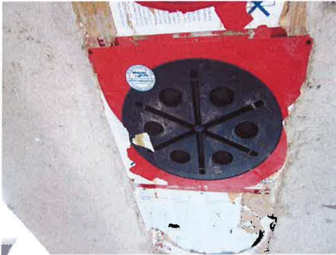
Abbildung 22: HSI 150 K2-100 mit Verschlussdeckel HSI 150-D (1 Versuch), Wannenunterseite nach 92 Tagen
