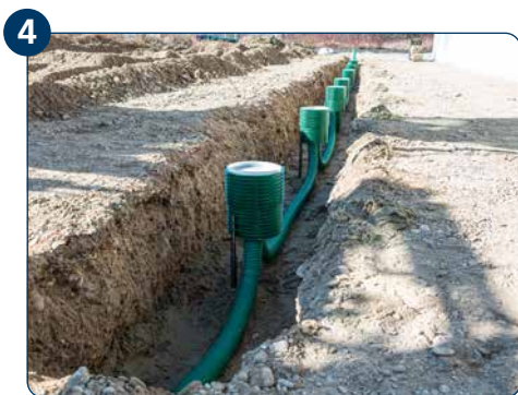
4 ETGAR-Leerrohrsystem DN 75 an Fundament-Boxen anschließen.
