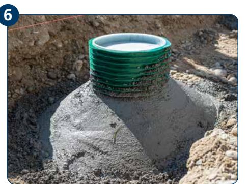
6 ETGAR Fundament-Box mit Magerbeton oder Estrichschnellzement fixieren.
