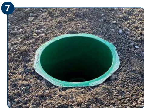
7 ETGAR Fundament-Box abschließend verfüllen.
