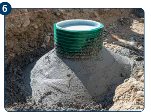
6 ETGAR Fundament-Box mit Magerbeton oder Estrichschnellzement fixieren.
