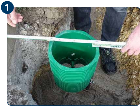
1 ETGAR Fundament-Box einmessen und Aufstellvorrichtung ins Erdreich „eindrücken“.
