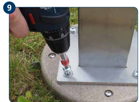
9 Endgeräte (Steckdosenleiste, Standleuchten) montieren.
