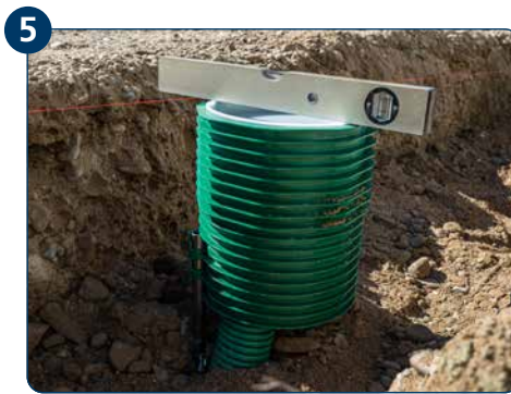
5 Graben lagenweise verfüllen und ETGAR Fundament-Box vor dem Betonieren ausrichten.
