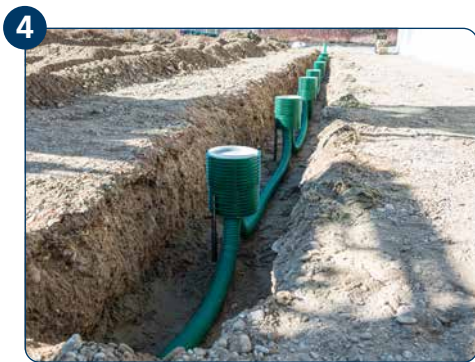
4 ETGAR-Leerrohrsystem DN 75 an Fundament-Boxen anschließen.
