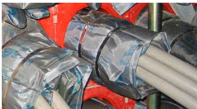
HSS – montage des coussins coupe-feu dans le passage étanche HSI150 K2, étanchéification avec couvercle ou SEGMENTO
