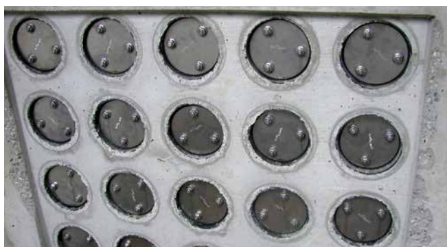
FZR100/240 – étanchement, tracé des tuyaux
