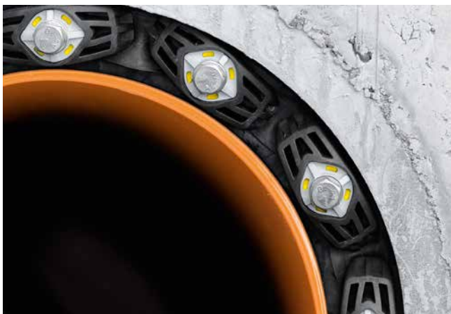
GKD – entièrement monté – tous les regards sont complètement marqués en jaune.
