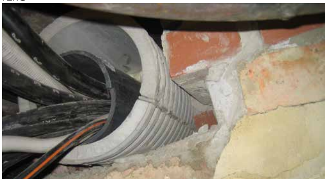
FZRG150/350 – assainissement dans la maçonnerie
