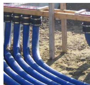
Rangées de HSI150 1x6 KVB150, pour introduction dans le sol du flexible spirale Hateflex14150
