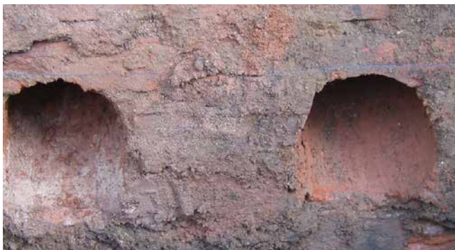
carottage incliné dans un mur poreux
