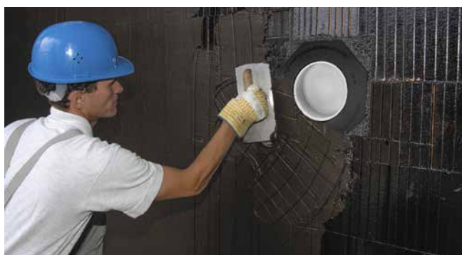
bétonné UFR avec PMBC
