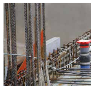
HSI901x1 KVB90 pour l'introduction dans le mur et dans le sol du flexible spiralé Hateflex1409
