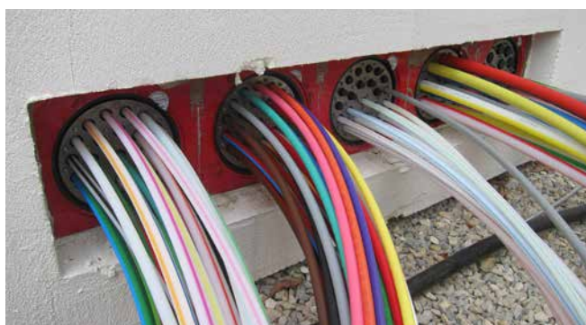
Insert mural HSI150 équipé de HRD150 21x14 b60 A2/EPDM55 pour sceller les micro tuyaux
