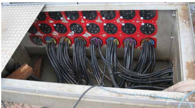
HSI150 – passages étanches avec étanchéification SEGMENTO des lignes de commande dans une cabine de distribution
