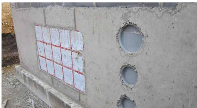
ZVR150 et ZVR200 bétonné près de HSI150
