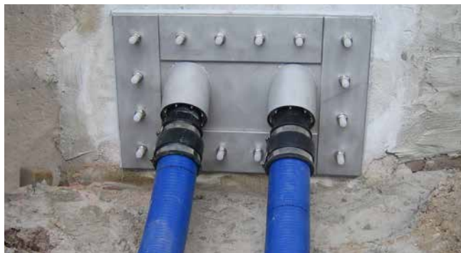
bride fixe/amovible avec raccordement de gaine incliné avant l'étanchéification superficielle
