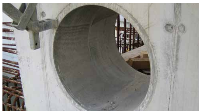
FZR400/300 – lieu de montage station d'épuration
