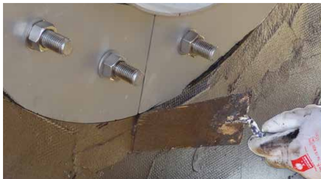
FLFE 300/X version acier inoxydable liée au revêtement bitumineux épais plastique modifié à l'aide d'une garniture d'étanchéité non tissée
