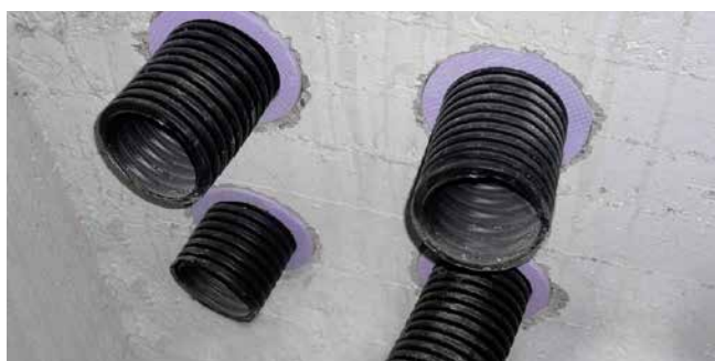
vue côté intérieur du bâtiment (joint Iso)
