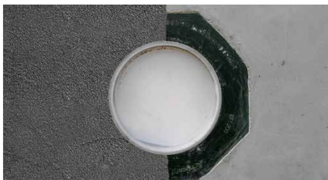
bétonné UFR avec PMBC
