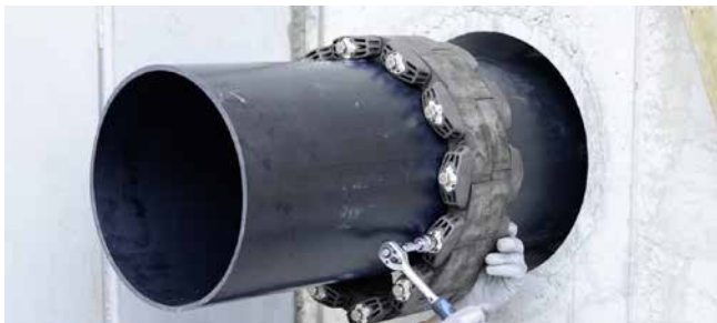
GKD400 – serrage des segments
