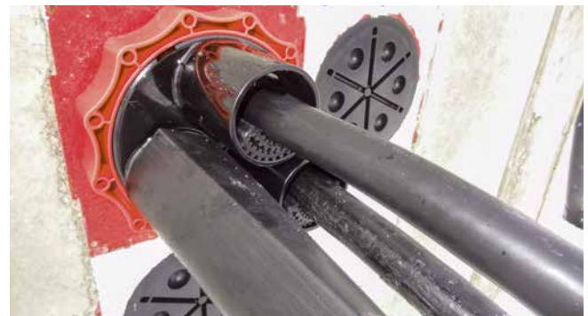
ruban de centrage dans la tubulure du couvercle du HSI150 D3x58 WS
