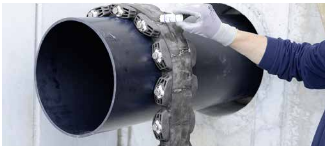
GKD400 – préparation de l'installation avec lubrifiant GM
