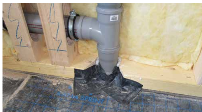
Dificultad: Unión de la barrera de vapor
