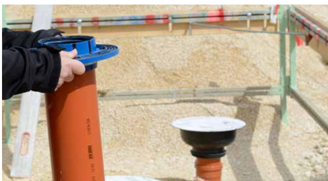
Montaje rápido y sin herramientas
