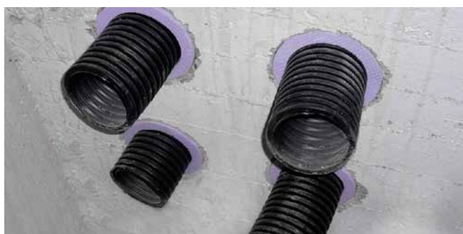
Vista del interior del edificio (anillo aislante)
