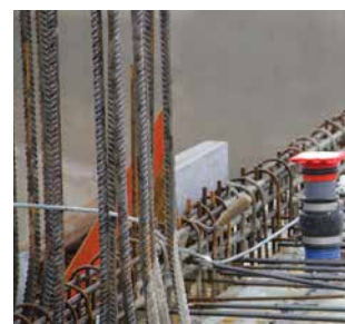
HSI901x1 KVB90 como entrada al suelo y la pared de la manguera espiral Hateflex14090
