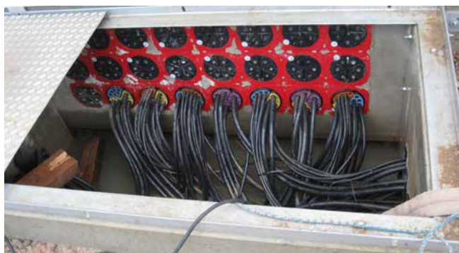
Insertos de pared HSI150 equipados con impermeabilización SEGMENTO de cables de control en caseta
