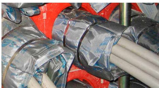
HSS – Instalación de tabletas anti fuego en inserto de pared HSI150 K2, sellado con cubierta del sistema o SEGMENTO
