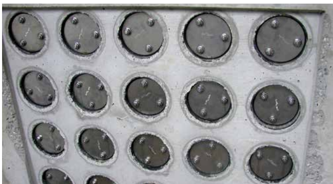
FZR100/240 Sellado de canalizaciones
