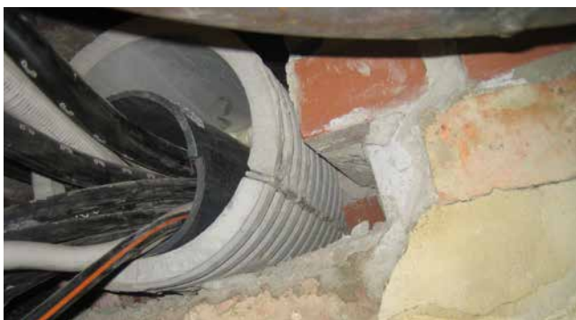
FZRG150/350 – Restauración de la mampostería
