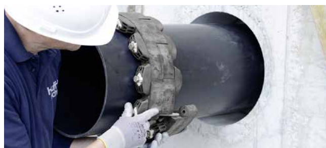
GKD400 – colocación de los segmentos
