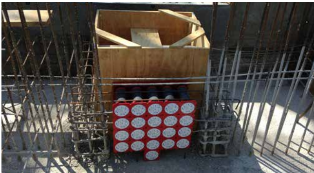
Montaje de inserto de pared doble HSI90-K2 previo al hormigonado
