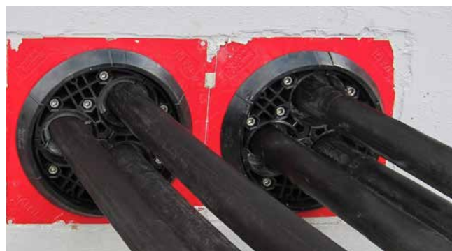
Diferentes pasos de montaje en HSI150 DG 3x24-54
