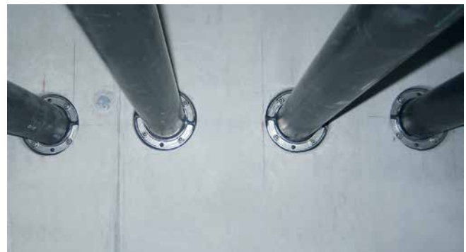
HSD125 1x75 b20 A2/EPDM55 empty conduit connection
