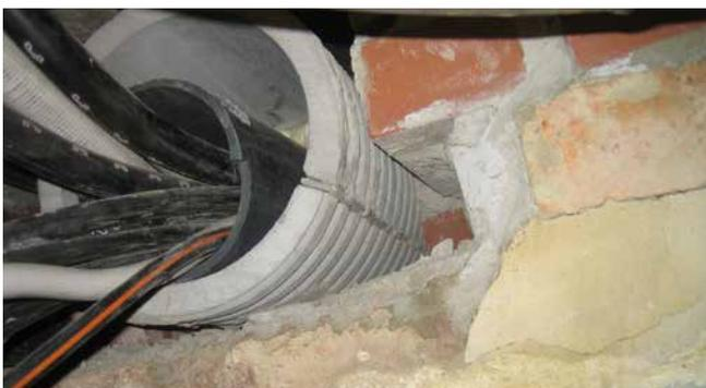
FZRG150 / 350 Sanierung im Mauerwerk
