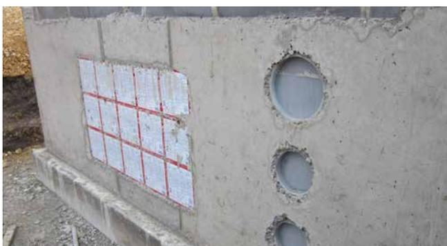
ZVR150 und ZVR200 einbetoniert neben HSI150
