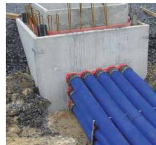
KES MA90 D – Anschluss an Dichtpackung HSI90
