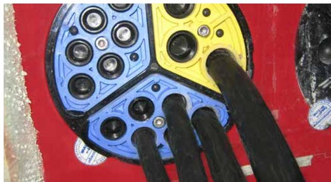
HSI150 SEGMENTO mit integrierter Drehmomentkontrolle und Blindstopfen
