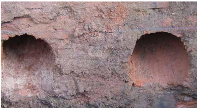
Schräge Kernbohrung in porösem Mauerwerk
