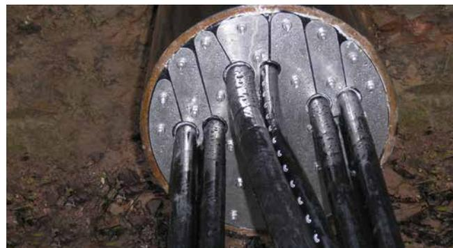
HRD200 G b30 in einem Stahlrohr
