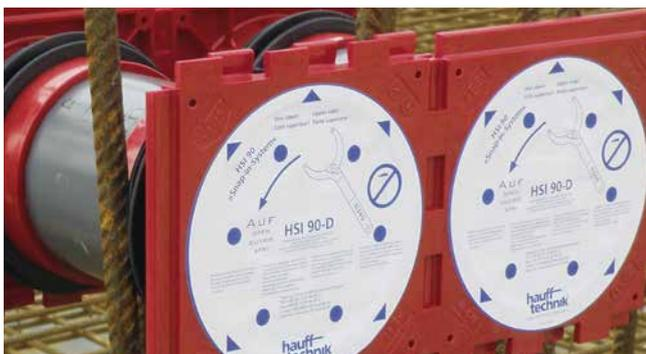
Doppeldichtpackung HSI90 als Paket in Schalung eingesetzt
