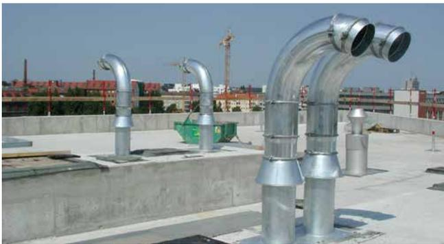
Montierte SHD200 vor Verlegung der Dachabdichtung
