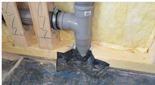
Schwierigkeit: Einbindung der Dampfsperre
