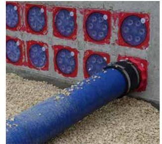
Druckdichter Anschluss an die HSI150-Dichtpackungen
