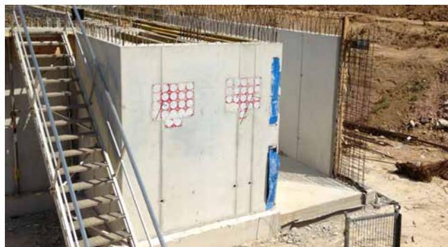
Paket HSI90 Doppel-Dichtpackung nach dem Betonieren:
