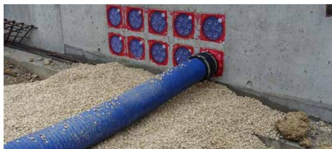
Anschluss des Kabeleinführungssystems KES MA150 D
