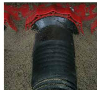
Wellrohranschluss mit Kaltschrumpftechnik HSI150 D1x110 KS WR
