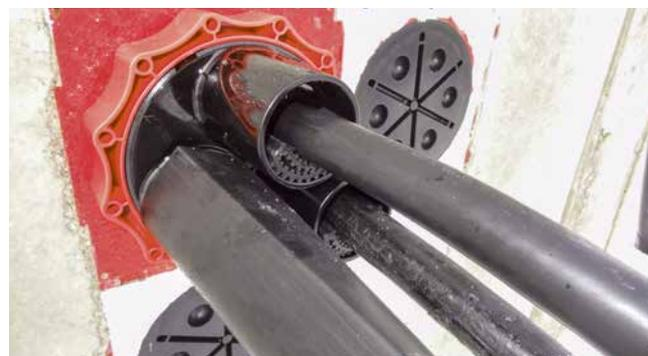
Zentrierband im Systemdeckelstutzen des HSI150 D3x58 WS
