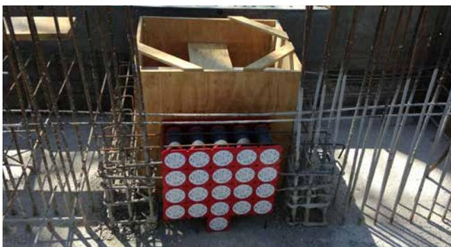
Einbau von Doppeldichtpackung HSI90 vor dem Betonieren
