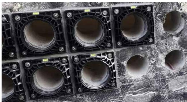
Kernbohrung und Dübellöcher
