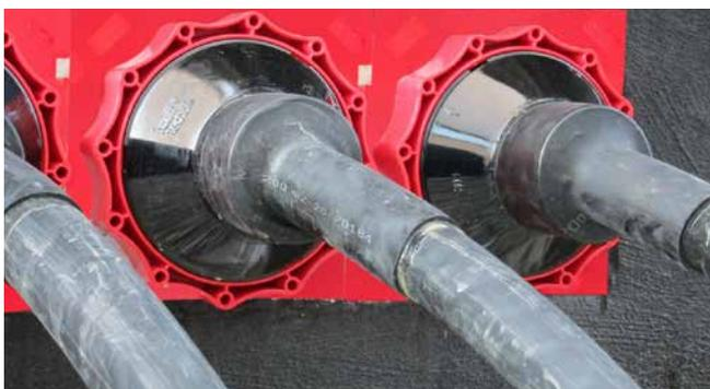
Stationseinführung: Niederspannungskabel abgedichtet mit HSI150 D1x80 WS
