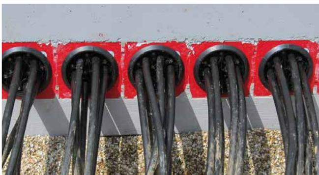
Abdichtung von Niederspannungskabeln mit HSI150 DG 6x10-36
