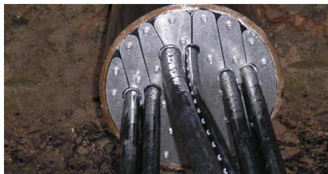
HRD 200-1G uszczelnienie w rurze stalowej
