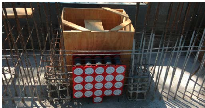
Dwustronne przepusty kablowe HSI 90-K2 przed zabetonowaniem
