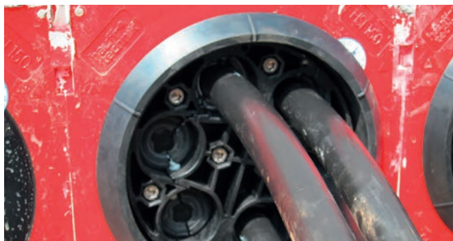
Uszczelnienie kabli za pomocą pokryw HSI 150-DG
