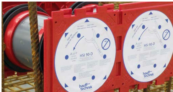
Dwustronny przepust HSI 90 zamontowany w szalunku
