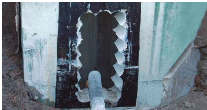
Betonowa ściana szybu, wprowadzenie rur osłonowych do kabli.
