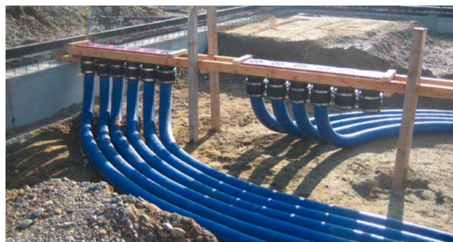
Wejście do budynku poprzez płytę fundamentową, konstrukcja wykonana na budowie (promień gięcia min. 1 m)
