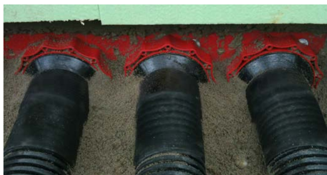
Uszczelnienie rur karbowanych pokrywą systemową z opaskami zimnokurczliwymi HSI 150-D 110-KS
