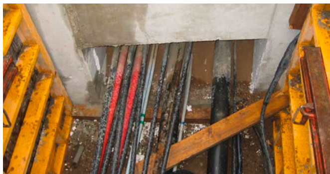
Prostokątny istniejący otwór, uszczelnienie kabli już ułożonych.
