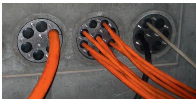
HRD 150-SG – uszczelnione kable w odwiercie w ścianie betonowej
