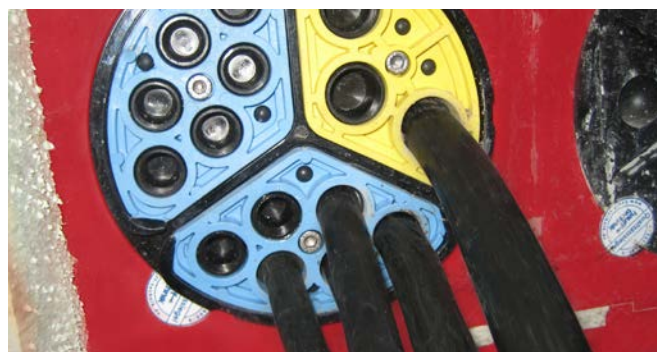
HSI 150 - SEGMENTO – punkty kontroli poprawności montażu oraz fabryczne zaślepki
