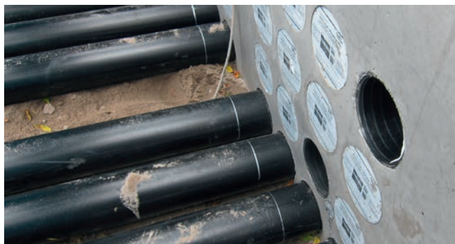
Przepusty HSI 150-GSM Varia połączone w pakiety i zabetonowane
