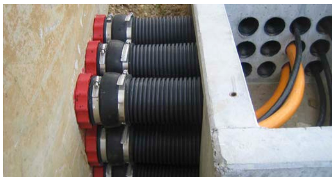
Uszczelnienie rur karbowanych pokrywą systemową w technice manszетowej HSI 150-M 168
