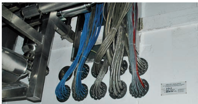
HRD 150-1G uszczelnienie wielu kabli w odwiertcie
