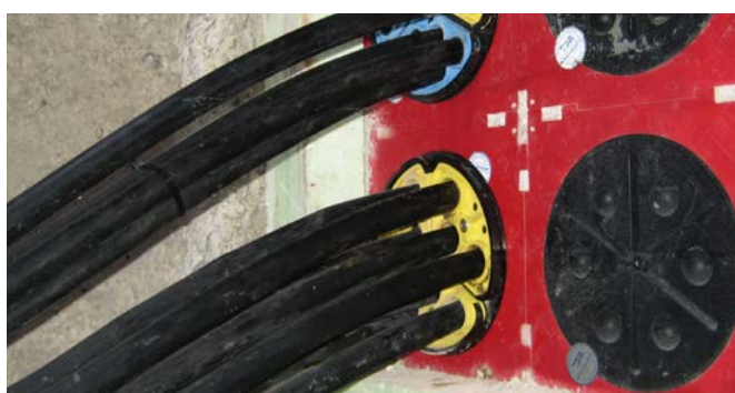
Uszczelnienie kabli oświetlenia ulicznego z zastosowaniem SEGMENTO
