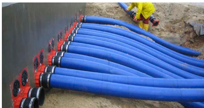
Szczelne połączenie rury Hateflex 14150 z pokrywą systemową HSI 150
