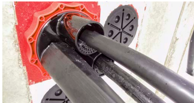
Taśmy centrujące zamontowane wewnątrz króćców pokrywy HSI 150-D3/58
