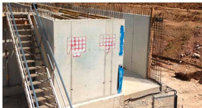
HSI 90-K2 po zabetonowaniu
