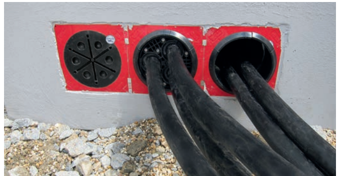
Różne fazy instalacji systemu HSI 150-DG-3/24-54
