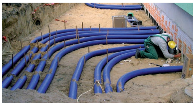
Szczelne połączenie rury Hateflex 14150 z pokrywą systemową HSI 150
