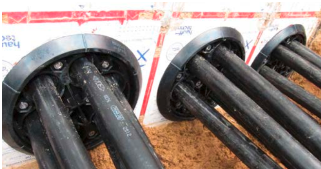
Kable uszczelnione przy pomocy HSI 150-DG-6/10-36
