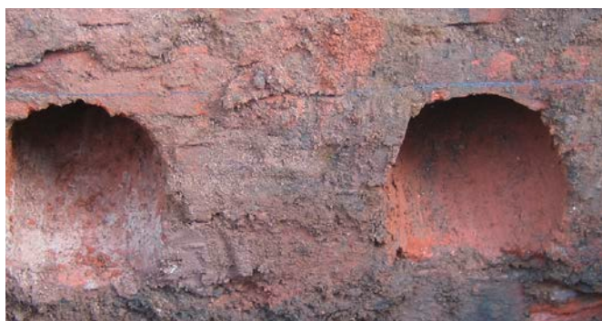
Otworowanie kątowe ściany murowanej.
