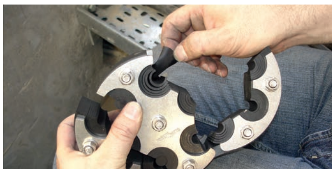
HRD 150-SG-6/8-35 – indywidualne dopasowanie wkładu do średnicy kabla na budowie
