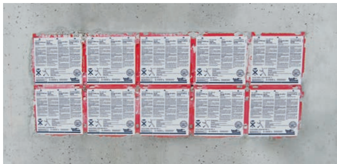
Pakiet dwustronnych przepustów HSI 150 zamocowany w szalunku
