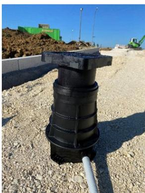
Durch die flexible G-Box kann die Höhe variabel angepasst werden. Ein einfaches Ziehen genügt, um die optimale Einbauhöhe zu definieren.
