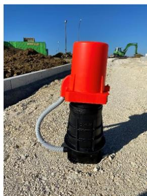
Die fertig montierte G-Box kann so im Neubaubereich eingebaut werden. Durch helle Wellrohre kann der fertige Stecker mit einem Kabelsystem direkt an den Router angeschlossen werden.
