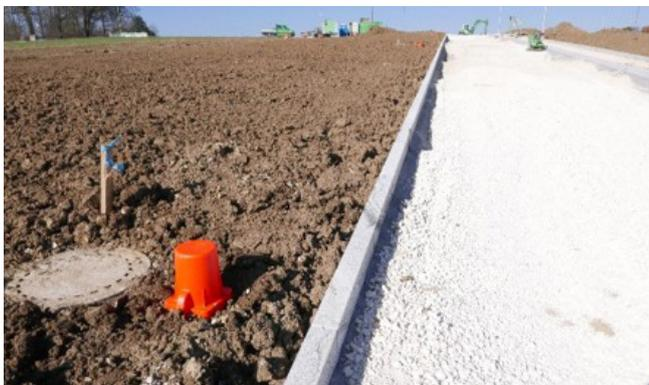
Die Pylone kennzeichnet die G-Box, diese ist dadurch leicht im Neubaubereich erkennbar. Die Glasfaser-Mehrlänge kann hier unter der Pylone abgelegt werden.
