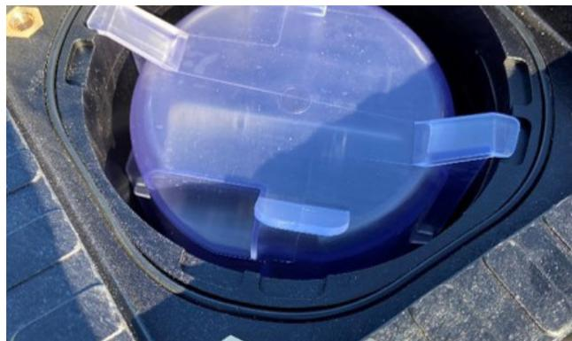
Der integrierte AP in der Box sorgt für problemlose Ablage der Pigtails und Anschluss des Kabelsystems in der G-Box. Gleichzeitig dient er als Messpunkt für die Strecke zwischen G-Box und NVT.
