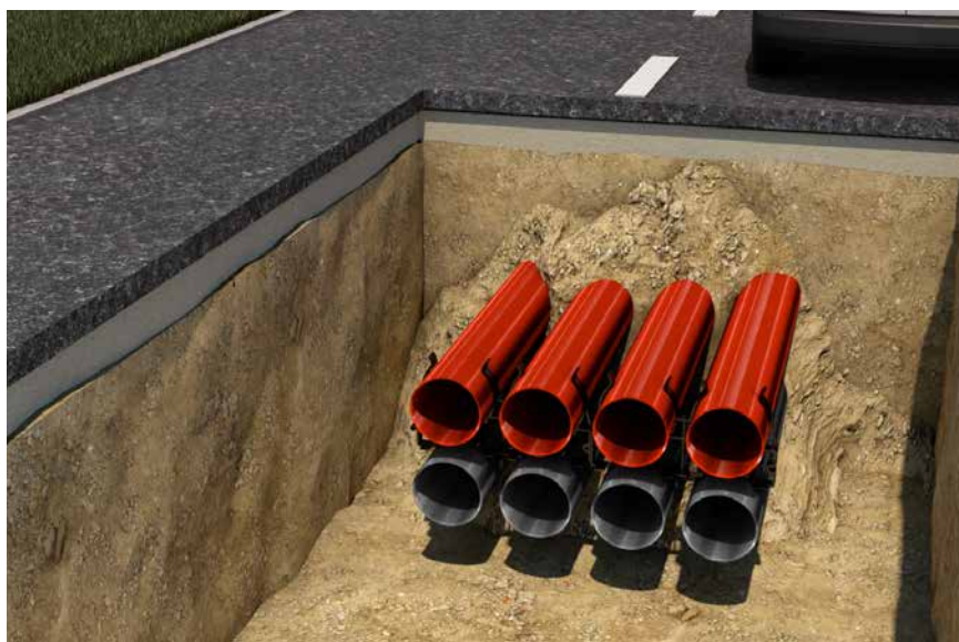
Profondeur de pose minimale des gaines de protection de câble pour le trafic lourd SLW60
