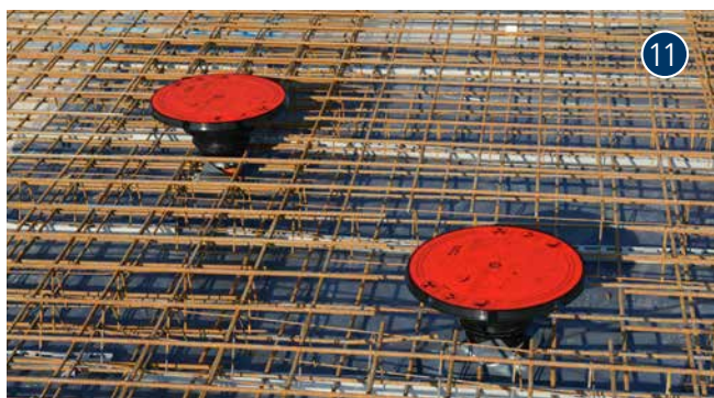
AT110 avant le bétonnage
