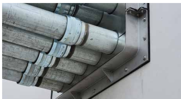
Brida de acero inoxidable partida para el posterior montaje con pasadores
