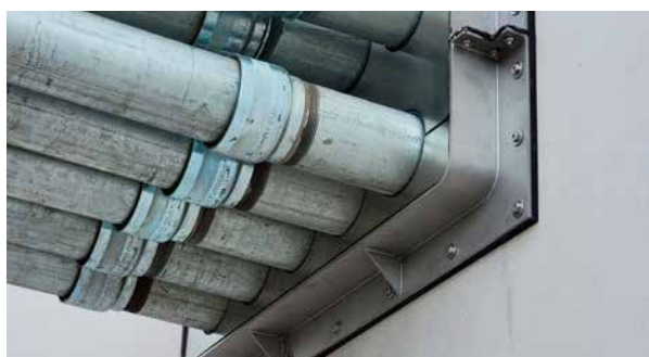
Brida de acero inoxidable dividida para el posterior montaje con pasadores
