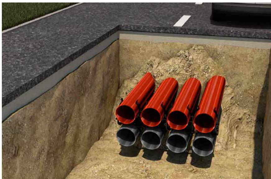
Minimale Verlegetiefe von Kabelschutzschläuchen bei Schwerlastverkehr SLW60
