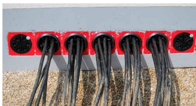
Abdichtung von Niederspannungskabeln mit HSI150 DG 6x10-36
