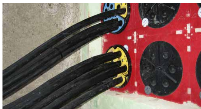
Abdichtung von Kabeln für Straßenbeleuchtung mit SEGMENTO
