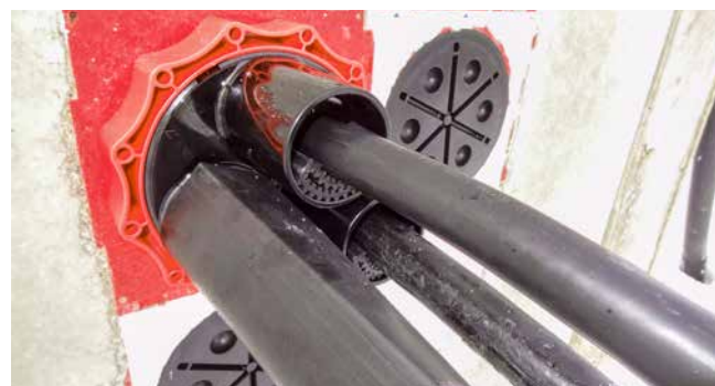
Zentrierband im Systemdeckelstutzen des HSI150 D3x58 WS
