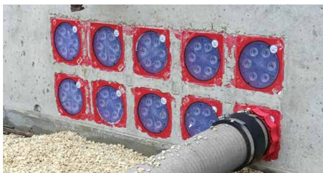
Druckdichter Anschluss an die HSI150-Dichtpackungen
