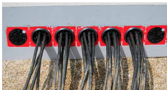
Abdichtung von Niederspannungskabeln mit HSI150 DG 6x10-36
