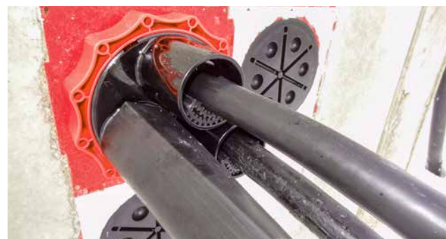
Zentrierband im Systemdeckelstutzen des HSI150 D3x58 WS
