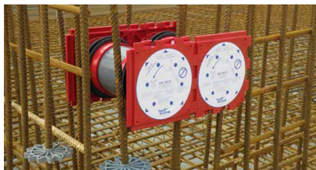
Doppeldichtpackung HSI90 als Paket in Schalung eingesetzt
