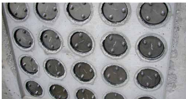
FZR100/240 Abdichtung Rohrtrasse
