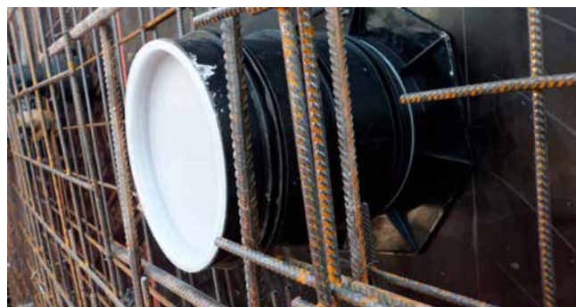
UFR in Schalung
