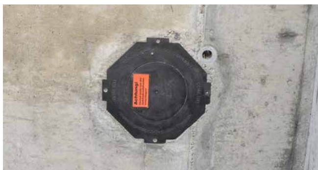
Praxisbild UDM/UDME in betonierter Wand
