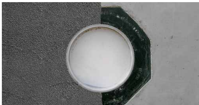
Betoniertes UFR mit PMBC
