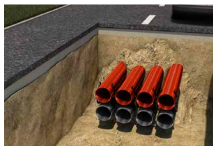
Minimale Verlegetiefe von Kabelschutzschläuchen bei Schwerlastverkehr SLW60
