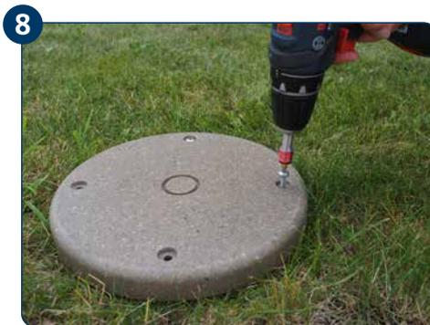
8 ETGAR Trägerplatte aufsetzen und über mitgelieferte Schrauben fixieren.
