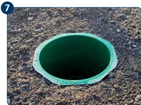
7 ETGAR Fundament-Box abschließend verfüllen.
