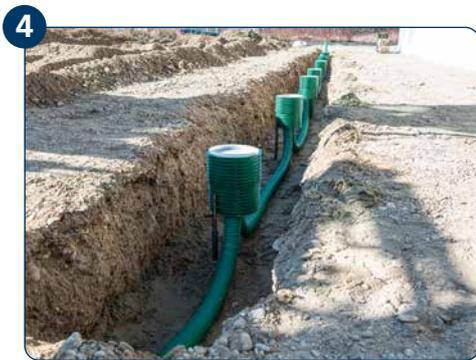
4 ETGAR-Leerrohrsystem DN 75 an Fundament-Boxen anschließen.
