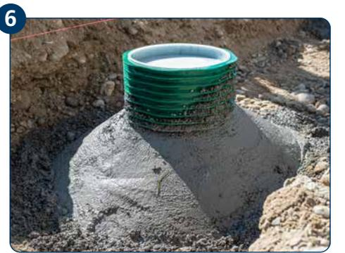
6 ETGAR Fundament-Box mit Magerbeton oder Estrichschnellzement fixieren.
