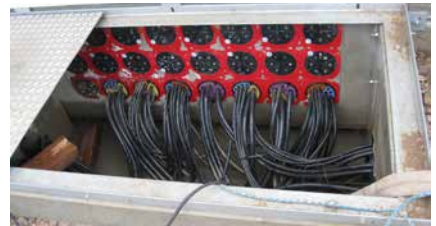
HSI150 - Dichtpackungen bestückt mit SEGMENTO-Abdichtung von Steuerleitungen in einem Schalttafel
