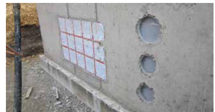
ZVR150 und ZVR200 einbetoniert neben HSI150
