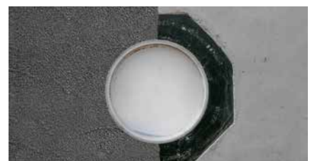
Betoniertes UFR mit PMBC
