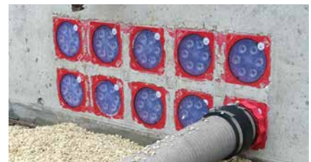
Druckdichter Anschluss an die HSI150-Dichtpackungen
