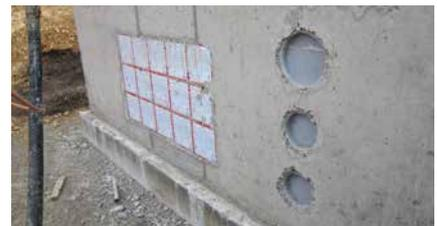
ZVR150 und ZVR200 einbetoniert neben HSI150
