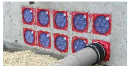
Druckdichter Anschluss an die HSI150-Dichtpackungen
