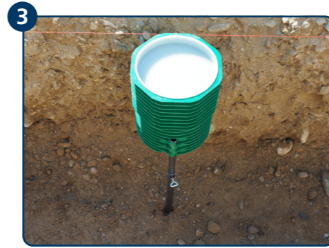
3 ETGAR Fundament-Box aufstecken, Höhe einstellen und über Flügelmutter fixieren.
