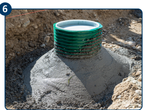
6 ETGAR Fundament-Box mit Magerbeton oder Estrichschnellzement fixieren.
