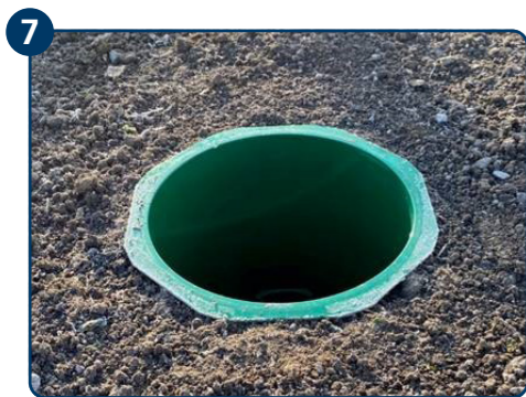
7 ETGAR Fundament-Box abschließend verfüllen.
