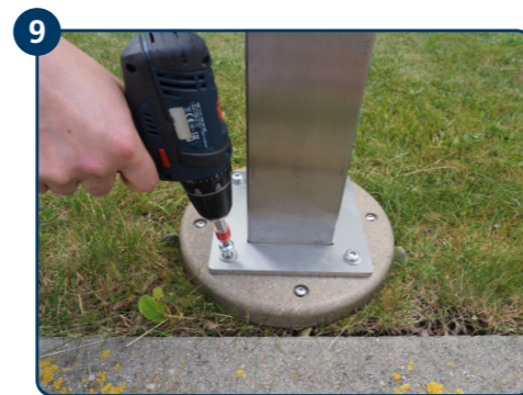
9 Endgeräte (Ladesäule, Steckdosenleiste, Standleuchten) montieren.
