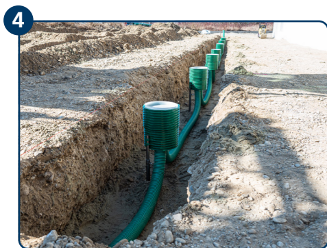
4 ETGAR-Leerrohrsystem DN 75 an Fundament-Boxen anschließen.
