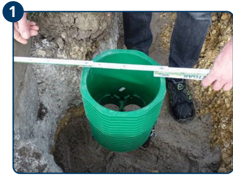
1 ETGAR Fundament-Box einmessen und Aufstellvorrichtung ins Erdreich „eindrücken“.
