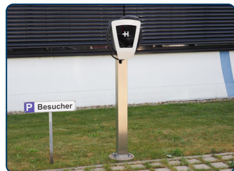
Ladesäule mit Wallbox
