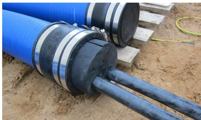
Il manicotto KES150 MA WE160 SG SET può essere impiegato sia come tappo a scomparsa, sia per mettere a tenuta il tubo flessibile spiralato. Mediante la tecnologia ad anelli segmentati è possibile adattare il diametro individuale del cavo in loco.
