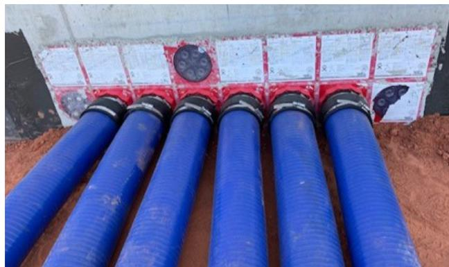
Il collegamento del tubo flessibile Hateflex ai passaggi impermeabili avviene mediante la copertura di sistema KES MA150 D.
