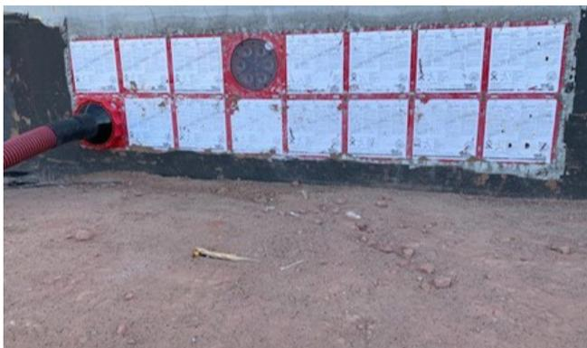
Dato l'elevato numero di inserimenti di cavi con doppi passaggi impermeabili HSI150 K2/x, è stato approntato un numero sufficiente di aperture di riserva.
