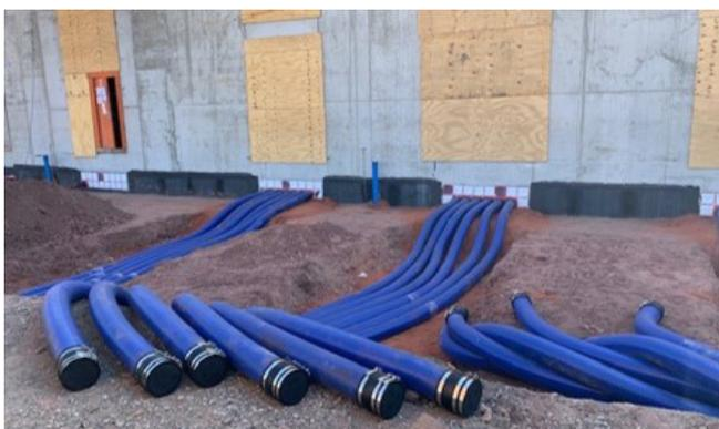
Grazie alle sue proprietà, il tubo flessibile spiralato Hateflex consente stabilità di forma, resistenza alla piegatura, resistenza alla costruzione, alle intemperie e ai raggi UV: i requisiti migliori per una posa di cavi sicura e delicata.
