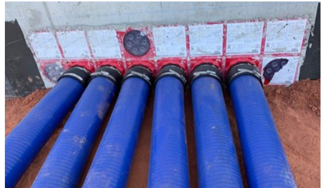
A Hateflex-tömlő a KES MA150 D rendszerfedéllel csatlakozik a tömítőcsomagokhoz.
