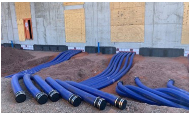
A Hateflex spiráltömlő az olyan tulajdonságai miatt, mint a formatartó képesség, törésállóság, ráépíthetőség, időjárás- és UV-állóság, a legjobb feltételeket teszi lehetővé a biztos és kíméletes kábelelhelyezéshez.
