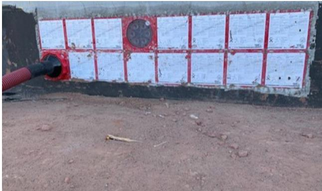
Kod broja kabelskih uvoda s dvostrukim zidnim uvodnicama HSI150 K2/x uzet je u obzir dovoljan broj rezervnih otvora.
