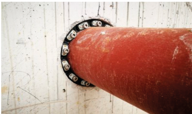
Vgrajeno tesnilo GKD 300 (izvrtina fi 200 mm in cevjo fi 160 mm).
