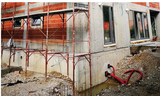
Vgrajeno tesnilo GKD 300 (izvrtina fi 200 mm in cevjo fi 160 mm).
