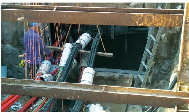
Se hizo un hueco alrededor de los cables tendidos y de las tuberías de protección y se montaron tuberías de revestimiento divididas alrededor de cada sistema de cables.
