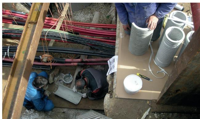
Montaje de los tubos de revestimiento de cemento de fibra partida FZR-G.
