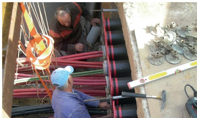
Instalación de empaquetaduras de sellado HSI 150-K2 y tubos de revestimiento partidos FZR-G.
