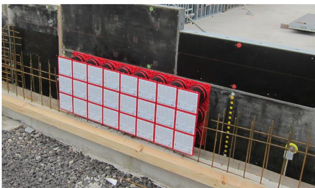
Alle Durchführungen sind standardmäßig mit dem druckdichten Verschlussdeckel HSI150 DT blind verschlossen und verhindern einen möglichen Wassereintritt. Der Verschlussdeckel befindet sich unterhalb der Schutzfolie.
