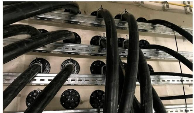
Innerhalb des Notstrom-Gebäudes wurden Ringraumdichtungen HRK-SSG verarbeitet.
