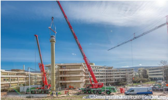
Ein 23 Meter hoher und 9 Tonnen schwerer Schornstein, per Tieflader transportiert und mit Schwerlastkran aufgerichtet, macht den Notstrom-Generator der Kopfklinik einsatzbereit.
