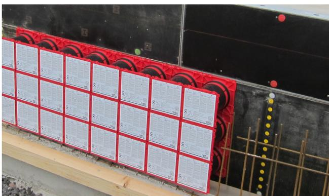
Tutti i passaggi sono chiusi ermeticamente con il tappo di chiusura a tenuta di pressione HSI150 DT e impediscono possibili infiltrazioni d'acqua. Il tappo di chiusura si trova sotto la pellicola protettiva.
