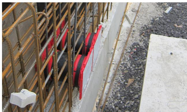
I passacavi sono stati incorporati nell'armatura e fissati alla cassaforma utilizzando i fori per chiodi previsti.
