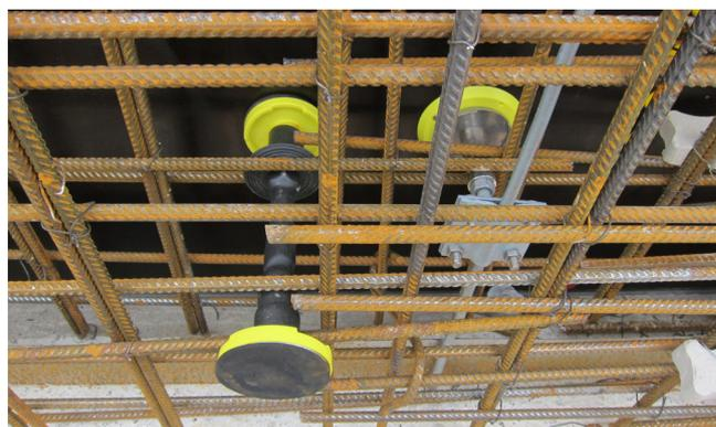
Per la messa a terra o il collegamento equipotenziale, vengono utilizzati diversi ingressi per la messa a terra e punti fissi di messa a terra. Questi sono legati nell'armatura e fissati in posizione. I punti fissi di messa a terra vengono collegati ai conduttori equipotenziali ancor prima della gettata di calcestruzzo.
