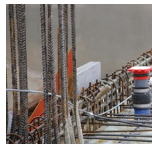
wyprowadzenie przepustu HSI90 1x1 KVB90 w szalunku posadzki
