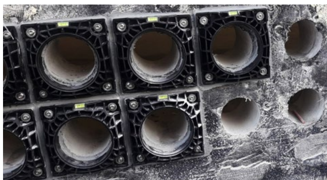
montaż flansz na przygotowanych otworach
