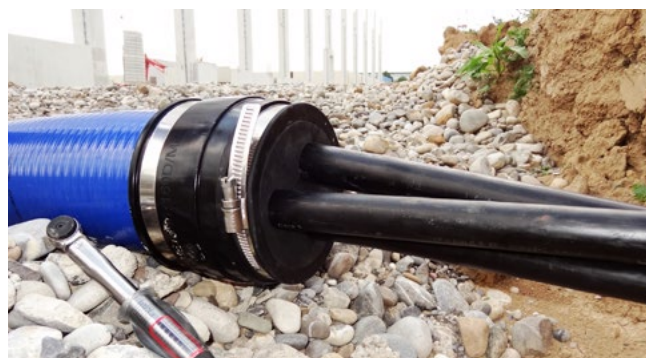
zamontowany mankieta KES150 MA WE 160 SG 3x22-58 SET
