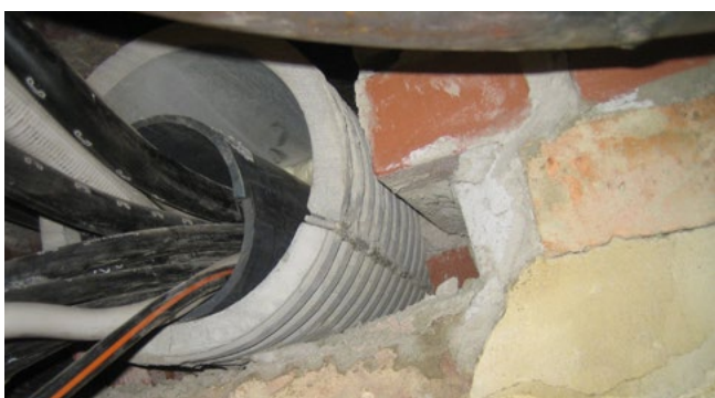
FZRG150/350 montaż w ścianie ceglanej
