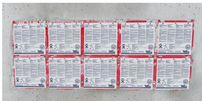
pakiet zabetonowanych przepustów HSI150 po rozszalowaniu
