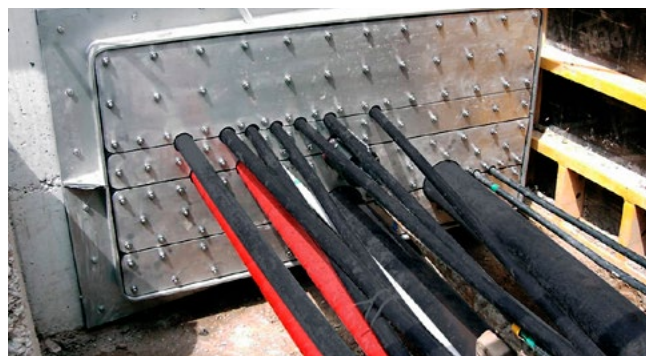
flansza w wersji dzielonej i ukośnie względem ściany
