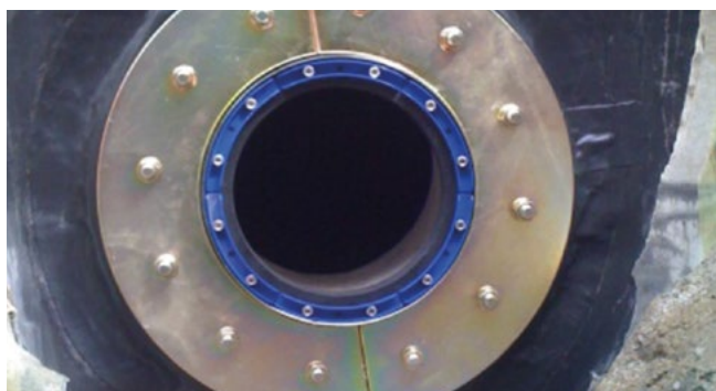
HSD200 C 1x159 b40 A2/EPDM55 w ocynkowanym kołnierzu uszczelniająco-mocującym
