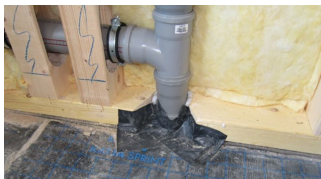
trudności z wykonaniem skutecznej izolacji
