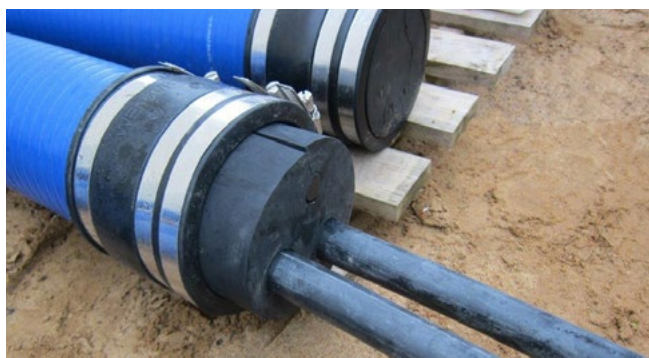
montaż mankietu KES150 MA WE 160 SG 3x 22-58 SET
