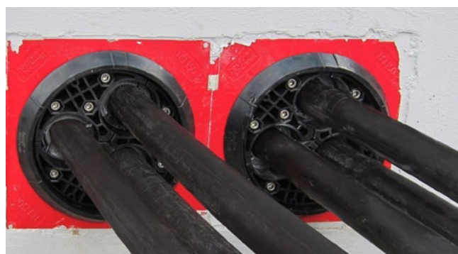
rożne fazy instalacji systemu HSI150 DG 3x24-54
