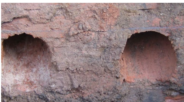
przewiert kątowy wykonany w ścianie z cegły
