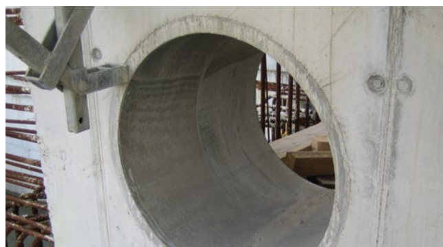
FZR400/300 zabetonowana w zbiorniku oczyszczalni ścieków
