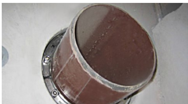
HSD200 1x160 b40 A2/EPDM55 instalacja odwodnienia deszczowego
