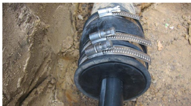
zestaw uszczelniający KES90 MA WE100 SG 1x18-65 SET do uszczelnienia kabla na końcu rury osłonowej
