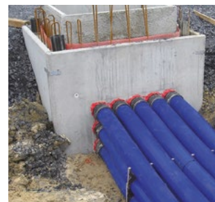
przyłączenie rury osłonowej Hateflex do zabetonowanego przepustu za pomocą pokrywy systemowej KES MA90 D
