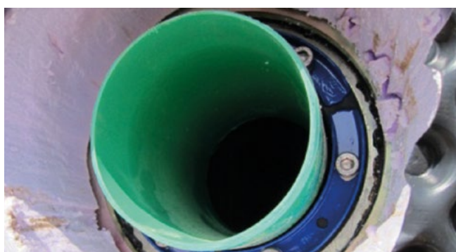
HSD-C 150/110 w ocynkowanym kołnierzu uszczelniająco-mocującym
