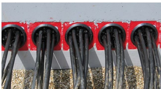
kable uszczelnione przy pomocy HSI150 DG 6x10-36
