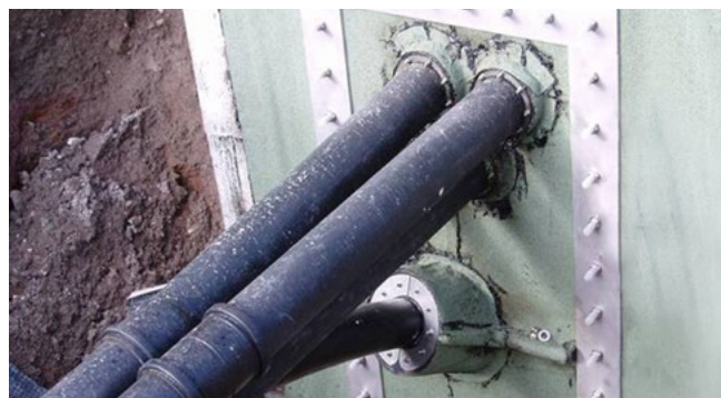
zastosowano flansze stalową oraz gumowe wkłady uszczelniające
