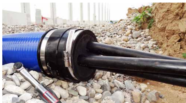
uszczelniającego KES150 MA WE 160 SG 3x22-58 SET
