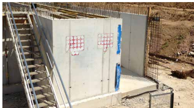
HSI 90 po zabetonowaniu
