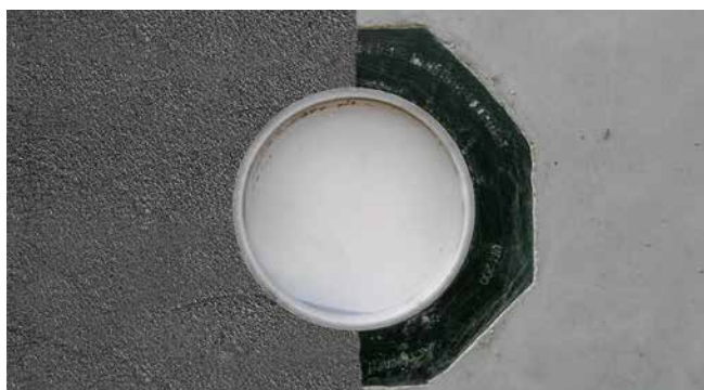
zabetonowany UFR z naniesioną powłoką hydroizolacyjną
