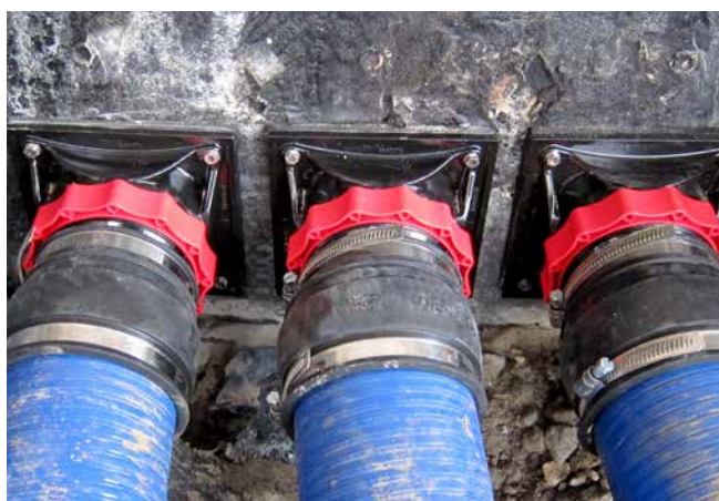
HSI90 DF z zamontowaną pokrywą systemową HSI90 MA110 WR
