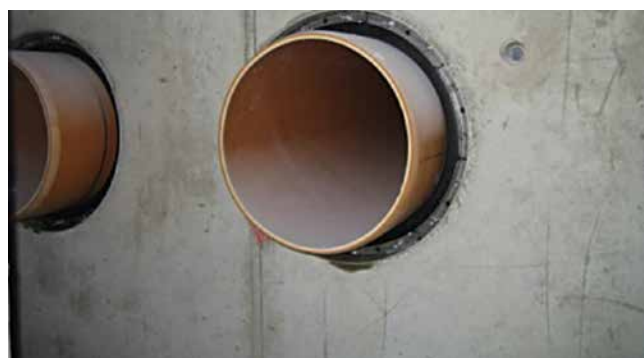
HSD500 G 1x429 b40 A2/EPDM55 napowietrzanie/odpowietrzanie
