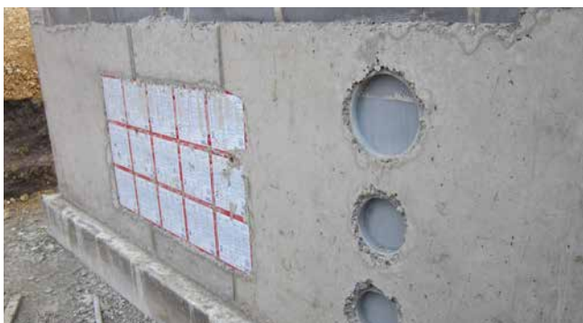
ZVR150 i ZVR200 set zabetonowane obok przepustów HSI150
