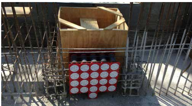
dwustronne przepusty kablowe HSI90 przed zabetonowaniem
