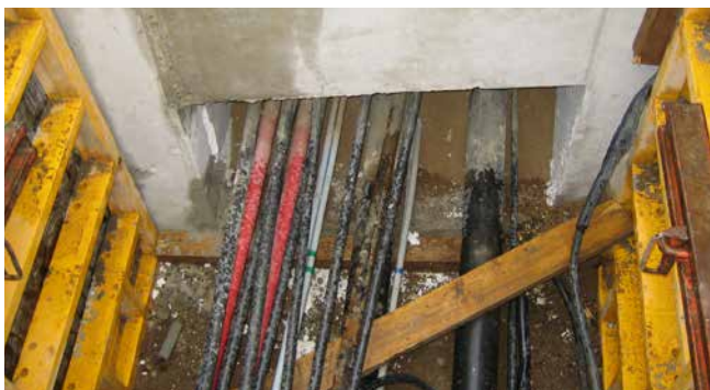
prostokątny istniejący otwór, uszczelnienie kabli już ułożonych
