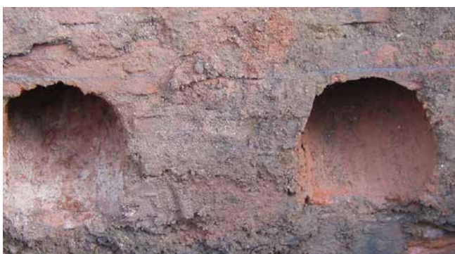
przewiert kątowy wykonany w ścianie z cegły
