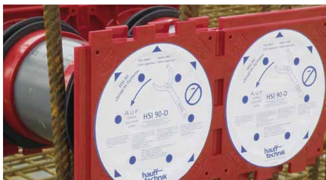
pakiet dwustronnych przepustów HSI90 zamocowany w szalunku
