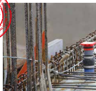
HSI901x1 KVB90 jako przepust w posadzce do węża spiralnego Hateflex 14090
