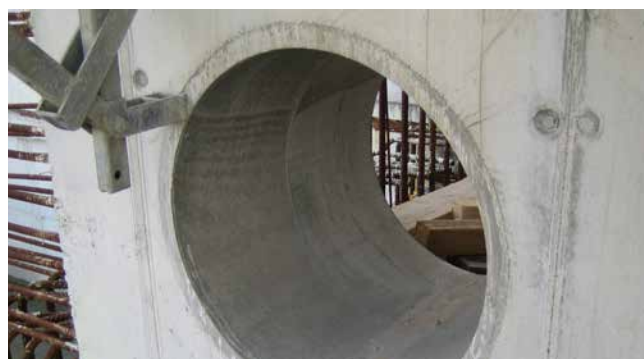
FZR400/300 zabetonowana w zbiorniku oczyszczalni ścieków
