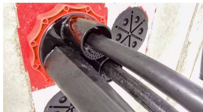
taśmy centrujące zamontowane wewnątrz króćców pokrywy f HSI150 D3x58 WS
