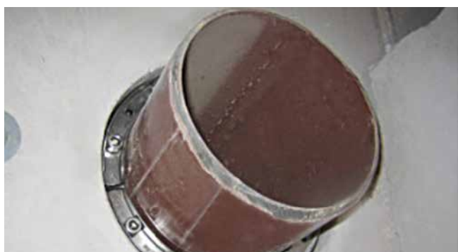
HSD200 1x160 b40 A2/EPDM55 instalacja odwodnienia deszczowego
