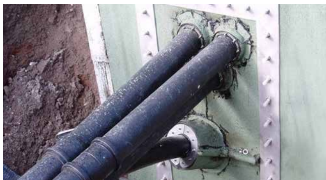
zastosowano flansze stalową oraz gumowe wkłady uszczelniające
