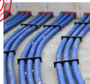
system prowadzenia i osłony kabli KES z użyciem elastycznej rury osłonowej Hateflex
