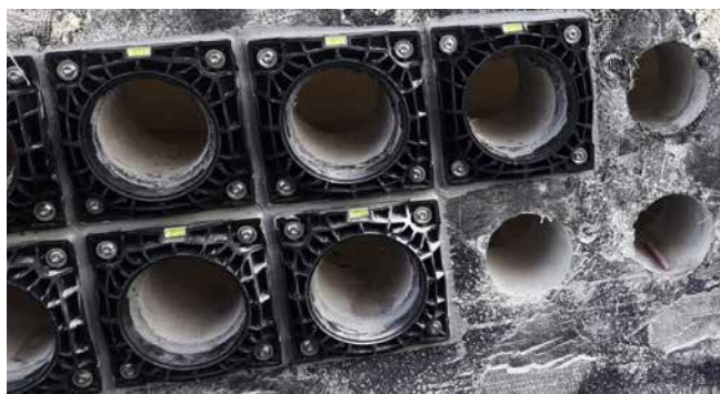
przewiert i otwory kołków rozporowych
