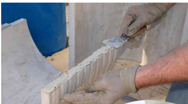
FZRG350/300 nanoszenie wypełniacza epoksydowego MSET FZRG
