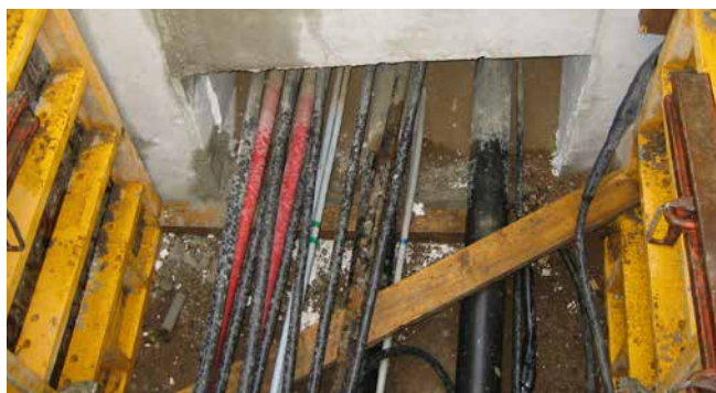
ukośne ułożenie rur i przewodów w otworze
