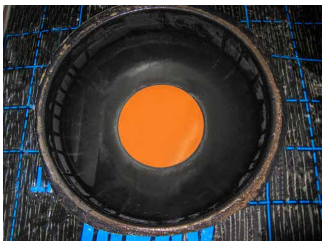
dzięki zastosowaniu dużego czola leja w łatwy sposób można dowieźć system izolacji
