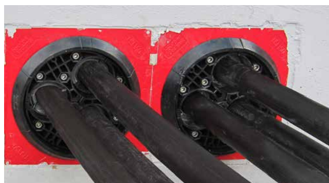
rożne fazy instalacji systemu HSI150 DG 3x24-54
