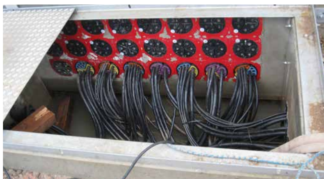
zabetonowane przepusty HSI150 wyposażone w pokrywy systemowe SEGMENTO z uszczelnionymi kablami sterowniczymi
