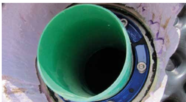
HSD-C 150/110 w ocynkowanym kołnierzu uszczelniająco-mocującym
