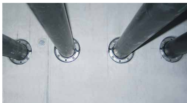
HSD125 1x75 b20 A2/EPDM55 uszczelnienie wprowadzonych rur
