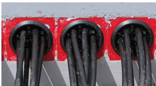
kable uszczelnione przy pomocy HSI150 DG 6x10-36
