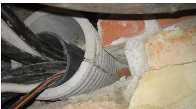
FZRG150/350 montaż w ścianie ceglanej
