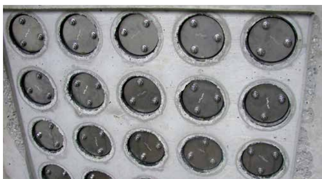
FZR100/240 po zabetonowaniu, zaślepione gumowymi wkładami zaślepiającymi
