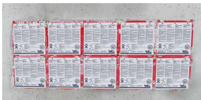
pakiet zabetonowanych przepustów HSI150 po rozszalowaniu
